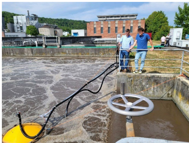
Abbildung 30: Ablufthaube zur Erfassung klimarelevanter Emissionen im Belebungsbecken der Kläranlage Ulm-Steinhäule (Bildquelle: variolytics GmbH).
