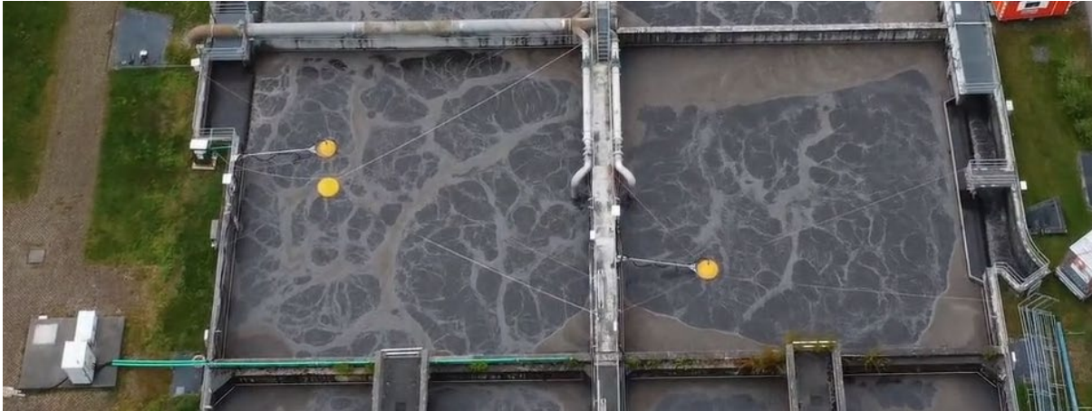
Abbildung 31: Anordnung der Messpunkte der N 2 O-Emissionsmessung in der belüfteten Zone der biologischen Reinigungsstufe der Kläranlage Ulm-Steinhäule (Bildquelle: Umwelttechnik BW GmbH).
