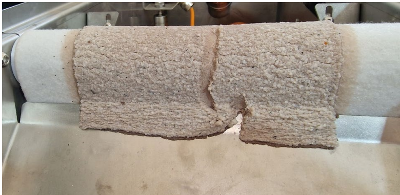
Abbildung 10: Ausgefällte P-Salze werden am Bandfilter abgestreift
