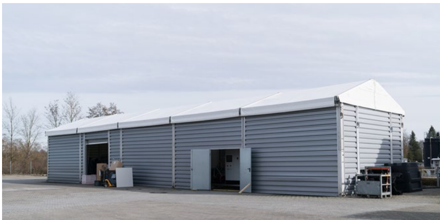
Abbildung 3: Zelt für RoKka-Pilotanlagen auf der Kläranlage Erbach
