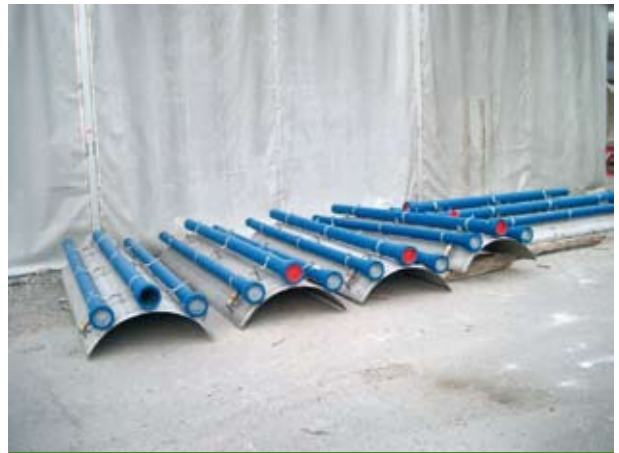
Wärmetauscher-Elemente vor dem Einbau. (Foto: Rabtherm)
