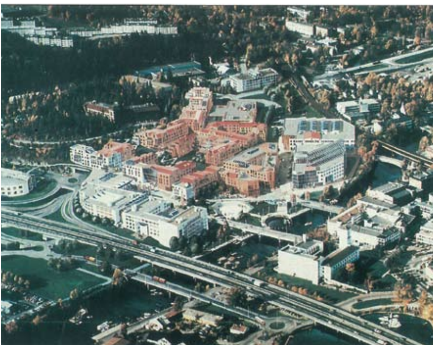
Das mit Abwasserenergie versorgte Zentrum von Sandvika.
