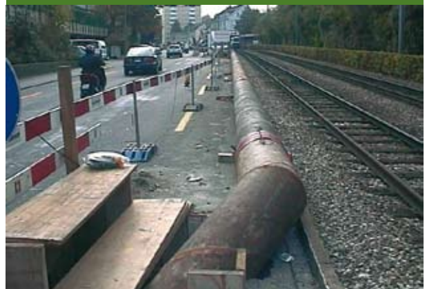
Umleitung des Abwassers während der Bauzeit. (Foto EBM)
