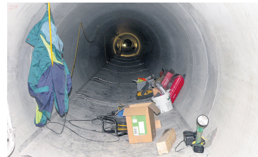
(3) Einbau Wärmetauscher Wässerwiesen
