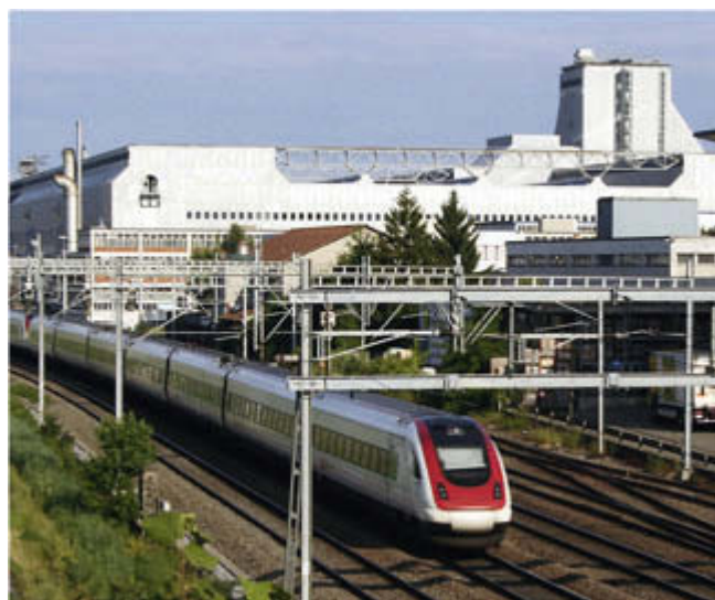
Abb. 5: Der silbern glänzende Gebäudekomplex der Post Mülligen wird mit dem Abwasser aus der Kläranlage der Stadt Zürich beheizt und auch gekühlt (Quelle: ewz)
