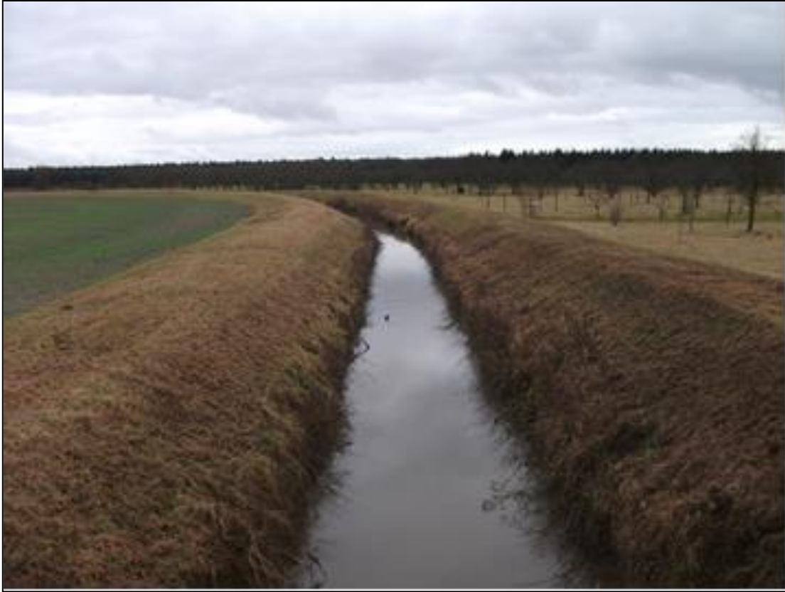
Abb.4: Eindeichung und Begradigung in der Oberrheinebene am Beispiel des Kriegbaches bei Kirrlach, Photo: J.Kändler, 2011)
