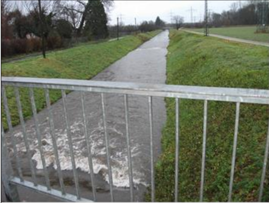
Abb.3: Eindeichung und Begradigung in der Oberrheinebene am Beispiel des Sandbaches bei Tiefenau, Photo: J. Kändler, 2011)
