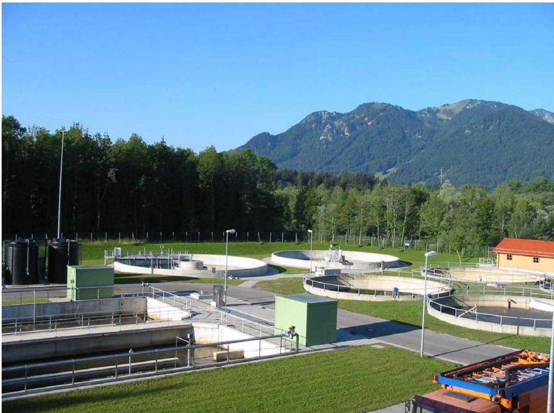
**Abbildung 2.3.2:** Dank umfangreicher Investitionen wird durch den Ablauf der Kläranlagen die Gewässergüte in der Regel nicht mehr verschlechtert. Das Bild zeigt die Anlage Lenggries an der Isar, die als zusätzliche Besonderheit eine UV-Bestrahlungsanlage zur Keimreduktion aufweist.
