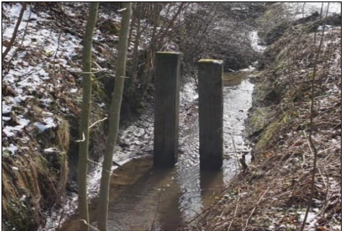
Abb. 4: Einfacher senkrechter Vorrechen in einem Biberrevier. Hiermit kann bereits vor den zu schützenden wassertechnischen Anlagen größeres Treibgut abgefangen werden.
