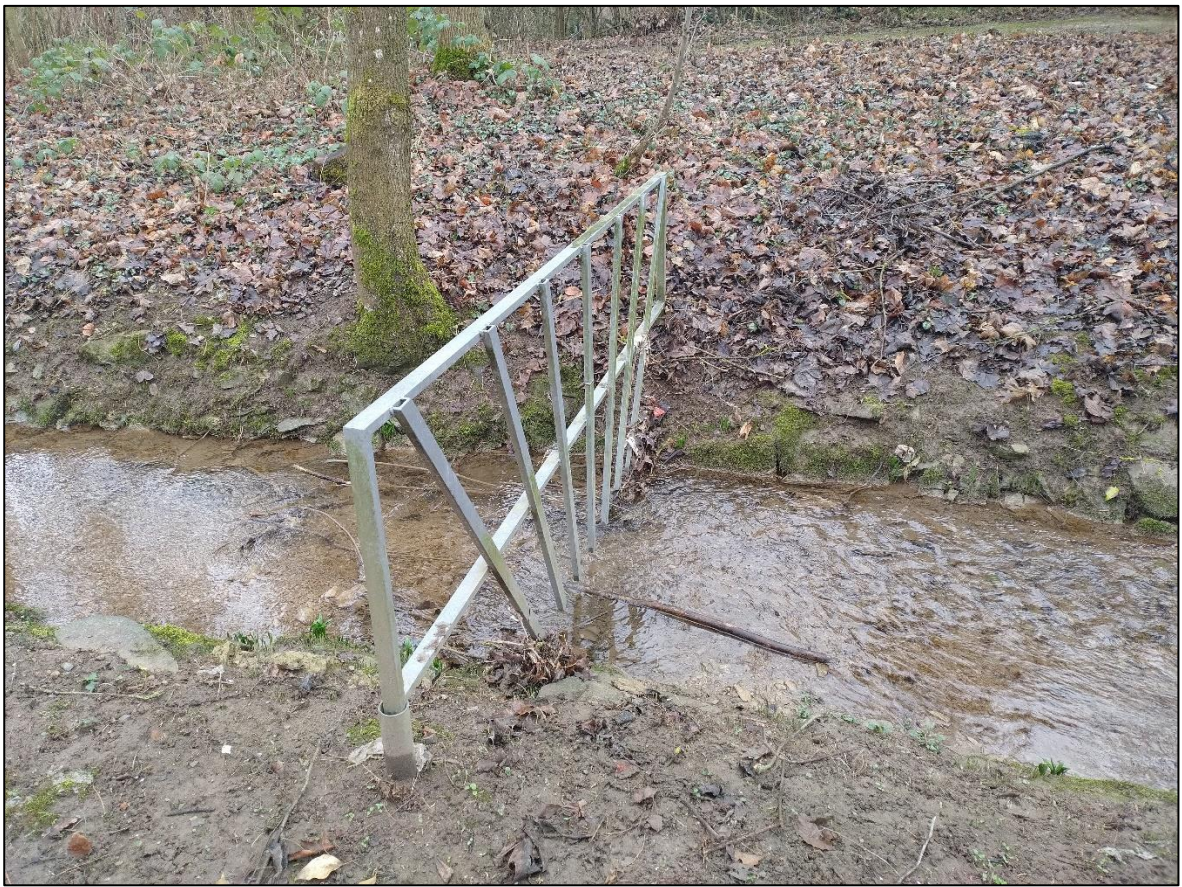
Abb. 7: Grobrechen aus Metall in einem Bachlauf. © Timo Skorzak
