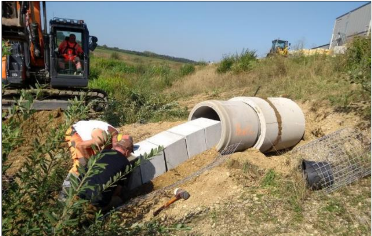
Abb. 1: Installation eines Biber-Kunstbaus. © Timo Skorzak
