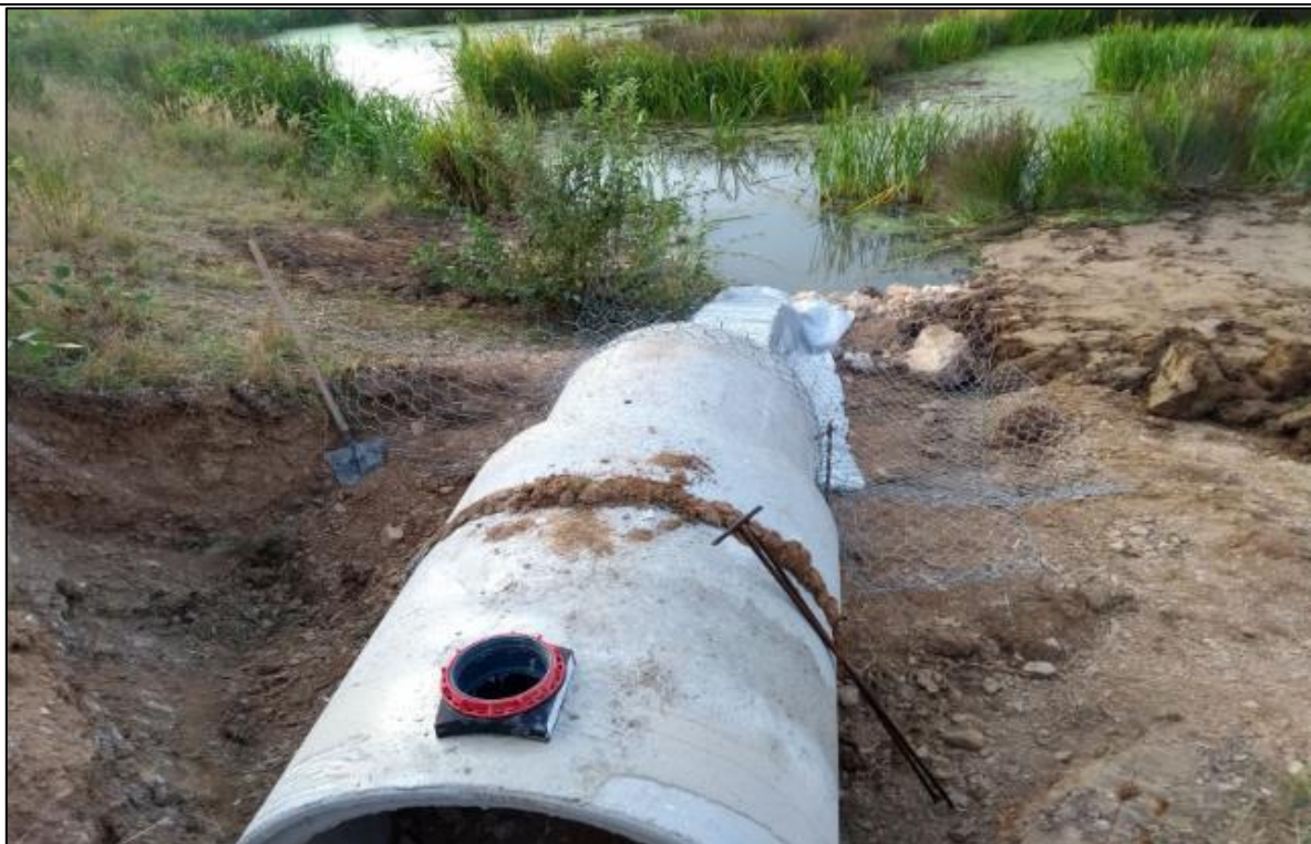
Abb. 2: Wohnkessel mit Kamera-Vorrichtung, Putzkammer und Zuwegung. © RPS
