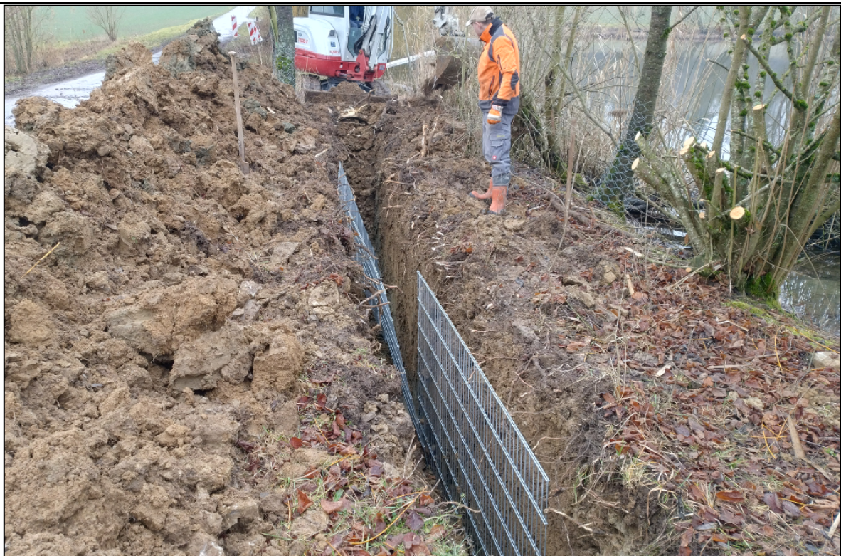
Abb. 2: Um ein Eingraben in den Dammbereich und Schäden an dem angrenzenden Weg zu vermeiden, wird ein „Biberschutzgitter“ eingegraben. © Timo Skorzak
