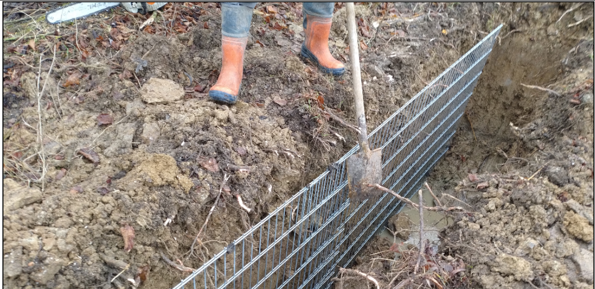
Abb. 1: Eingraben eines „Biberschutzgitters“ in der Bauphase. © Timo Skorzak
