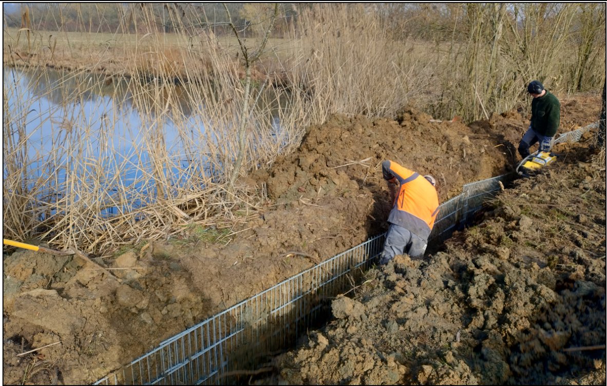
Abb. 3: Eingraben eines „Biberschutzgitters“ an einem Angelweiher. © Timo Skorzak
