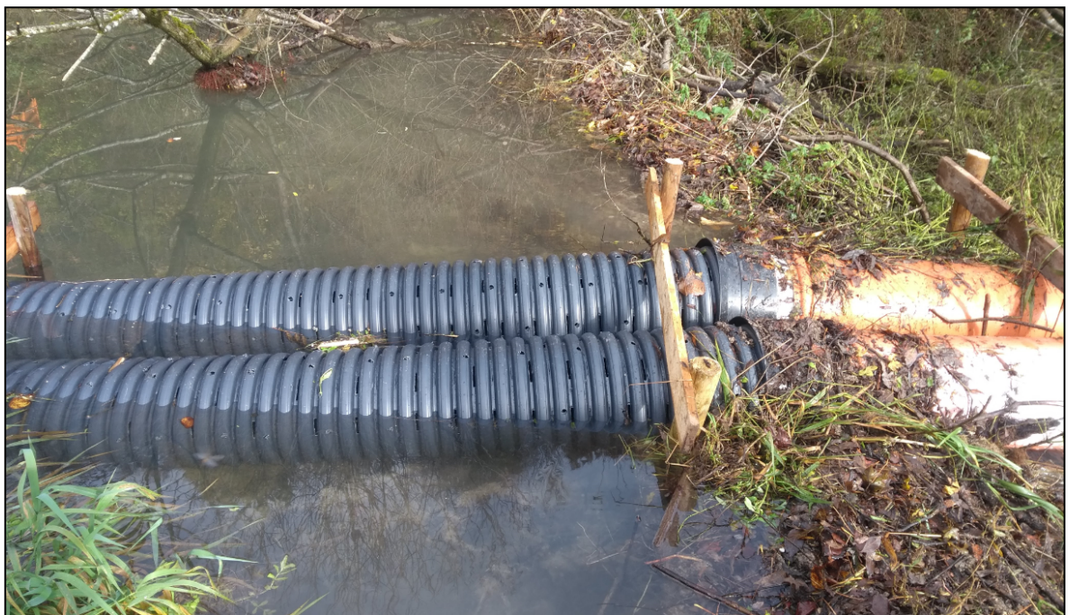
Abb. 11: Im Damm eingebaute Drainagerohre. Auch die doppelte Verlegung ist möglich (bspw. bei Gewässern mit möglichen hohen Durchflussmengen). © Timo Skorzak
