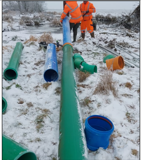
Abb. 1+2: Transport und vorbereitende Arbeiten vor Einbau einer Dammdrainage.
