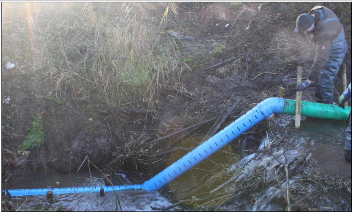
Abb. 4: Manueller Einbau einer Dammdrainage im Landkreis Sigmaringen. Gut zu erkennen sind die verwendeten Holzpflocke zur Fixierung der Rohre © Nicole Henninger
