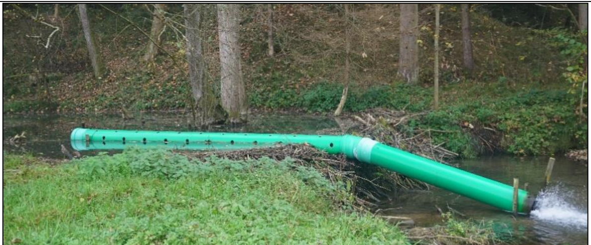
Abb. 3: Dammdrainage im Regierungsbezirk Tübingen. Sowohl die Rohrlänge oberhalb als auch unterhalb des Dammes sind hier relativ kurz und das Rohr wurde nur leicht in den Damm eingegraben. Im Idealfall sollten die Rohre aus dem Damm in beide Richtungen mind. 3 Meter herausragen. © Benjamin Unterseher
