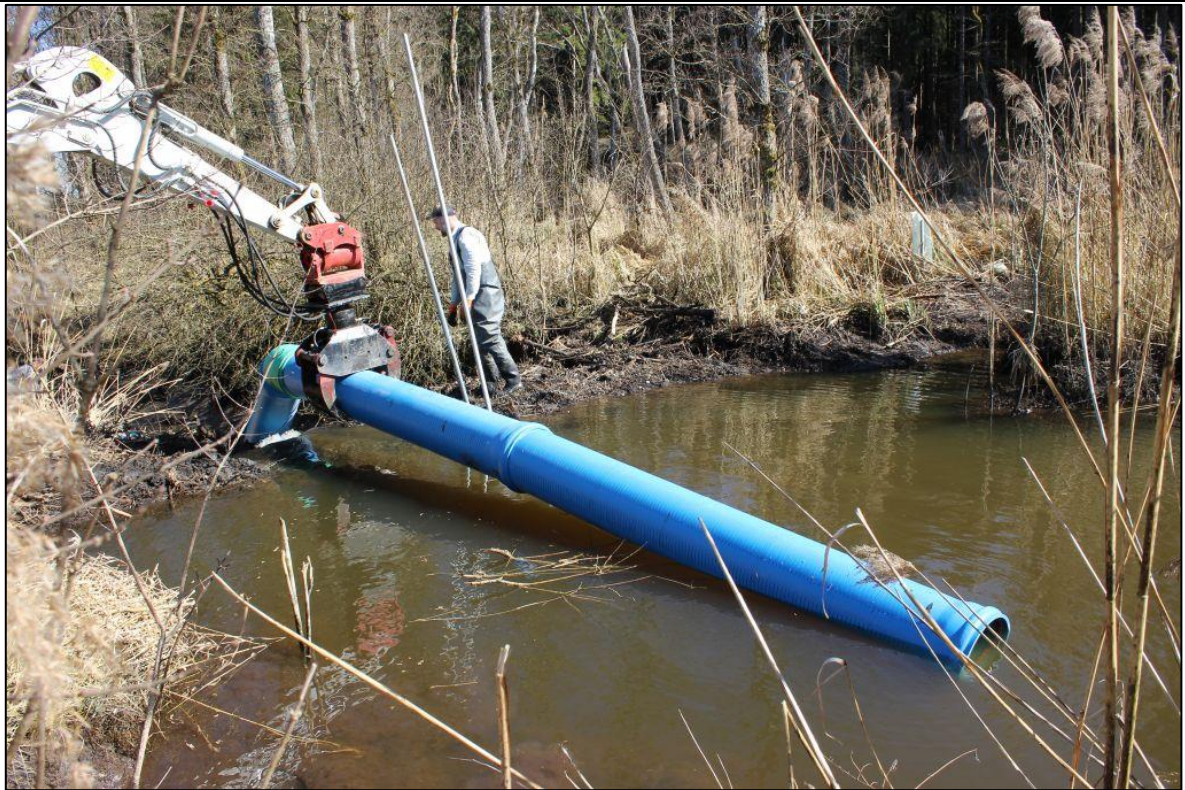
Abb. 6: Maschineller Einbau einer Dammdrainage mittels Greifer. © Nicole Henninger
