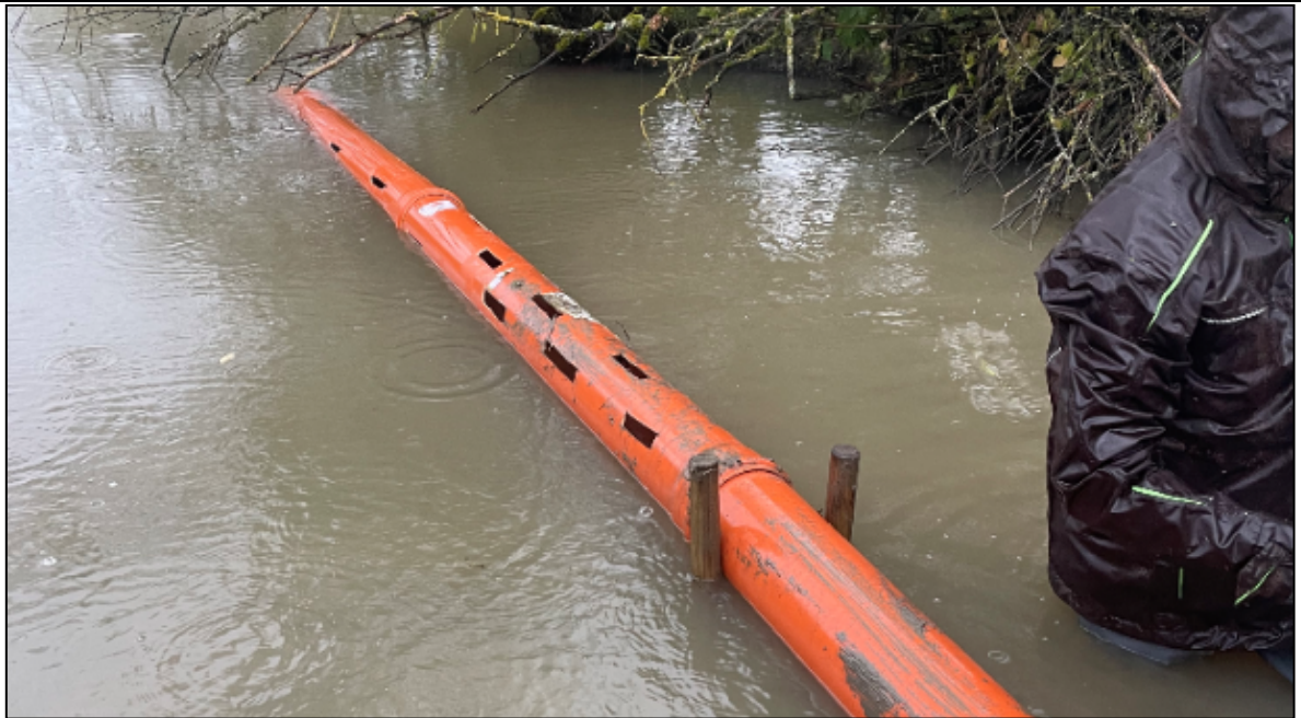
Abb. 10: Ein durch den örtlichen Bauhof selbst geschlitztes KG-Rohr. © Timo Wesner
