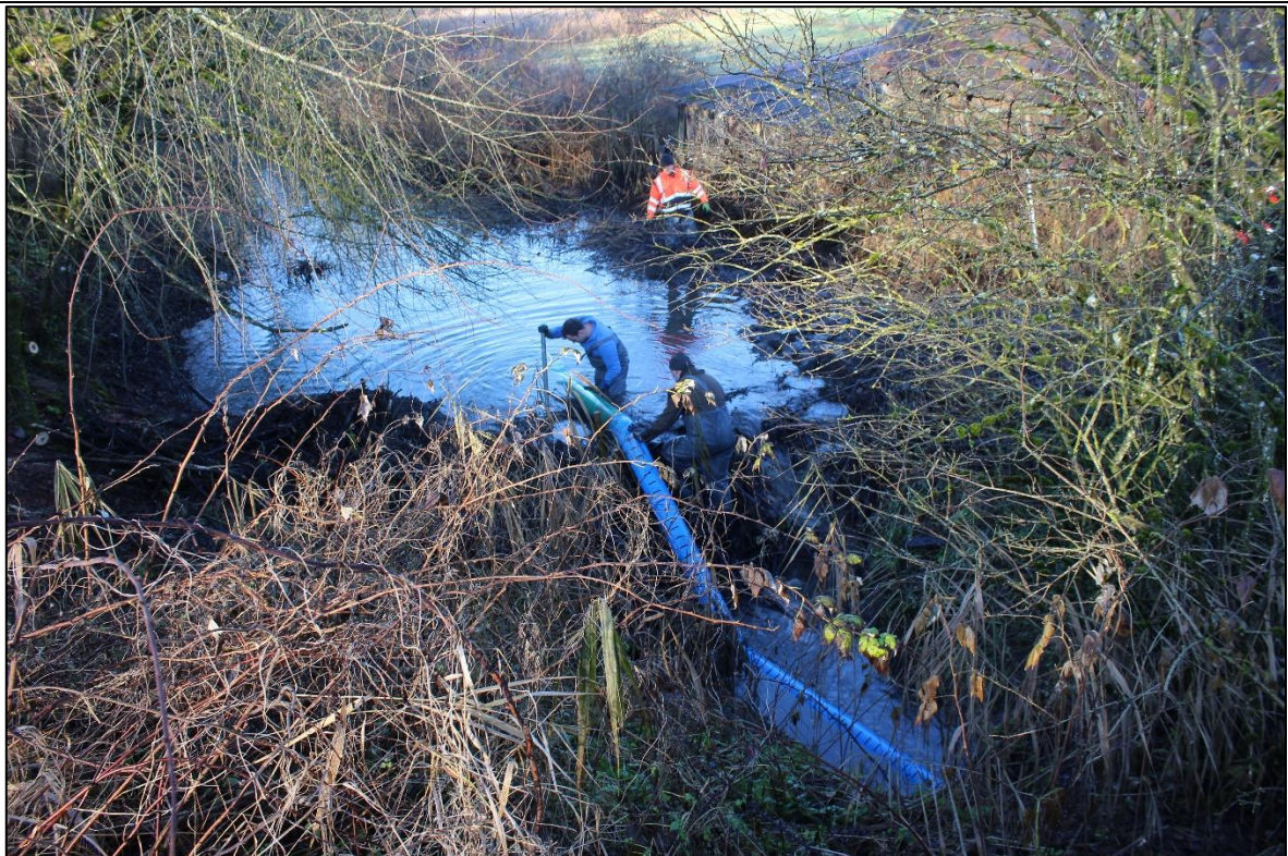
Abb. 5: Manueller Einbau Dammdrainage im Landkreis Sigmaringen. © Nicole Henninger
