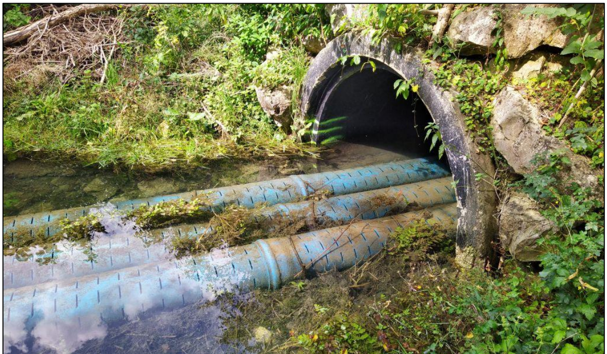
Abb. 7: Zur Gewährleistung des Wasserdurchflusses mit Drainagerohren versehene Verdolung. (Hinweis: In diesem Fall kann die Abflussleistungsfähigkeit der Verdolung eingeschränkt sein. Es ist vor Maßnahmenumsetzung eine enge Abstimmung mit der unteren Wasserbehörde notwendig). © Nicole Henninger
