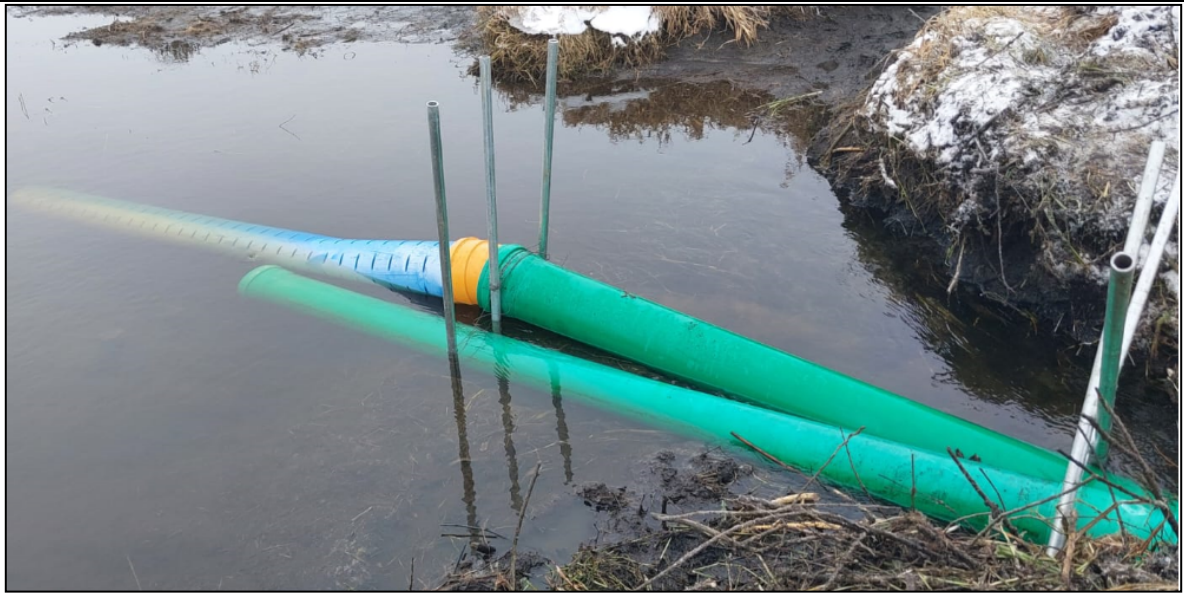
Abb. 8: Mit Metallstangen fixierte Drainagerohre © Konrad Frosdorfer
