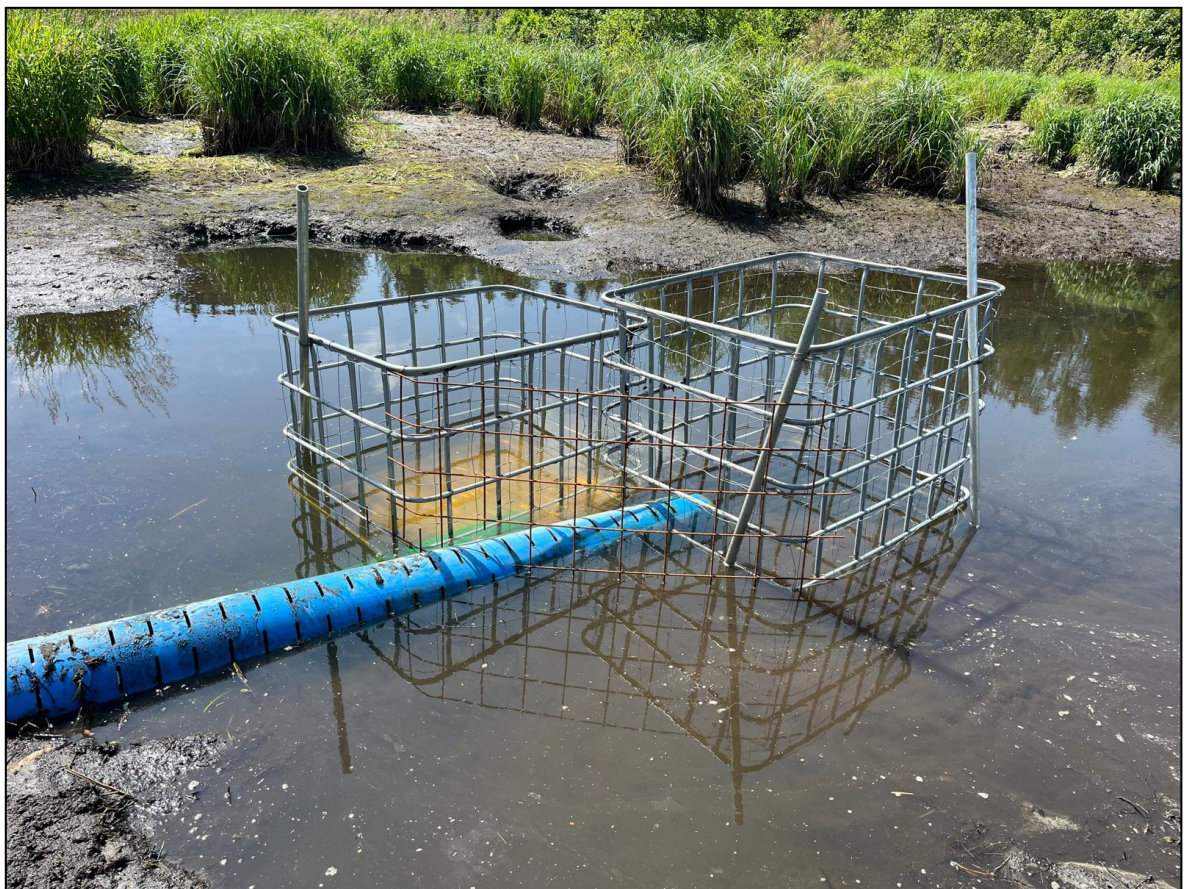
Abb. 9: Ein mit Metallkörben gesicherter Einlauf eines Drainagerohrs im Landkreis Sigmaringen. Hierdurch kann ein Verstopfen des Rohreinlasses durch den Biber deutlich erschwert werden. © Michael Uhl
