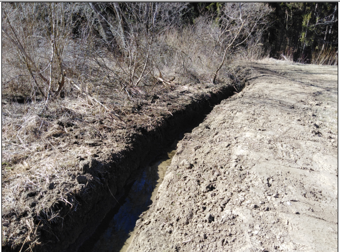
Abb. 4: Angelegtes Umgehungsgerinne, welches nur temporär Wasser ableiten soll.
