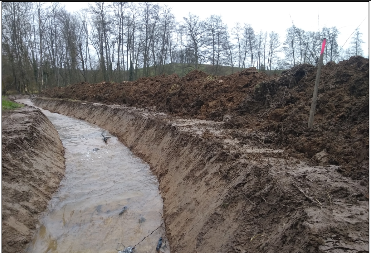
Abb. 5: Angelegter Bypass kurz nach Fertigstellung. © Dr. Ulrich Weinhold
