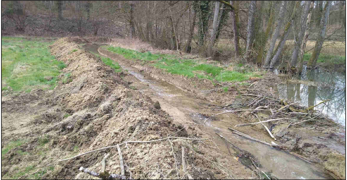
Abb. 1: Angelegtes Umgehungsgerinne. In der rechten Bildmitte ist der Biberdamm zu erkennen. Die Ausleitung des Wassers erfolgt hier weit oben im Rückstaubereich, was die Wahrscheinlichkeit erhöht, dass der Biber den Bypass nicht wieder aktiv zubaut.
