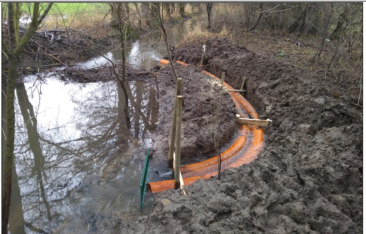
Abb. 6: Bypass mit Rohrleitung. Um ein Freispülen der Rohre zu verhindern, wurden diese mit Holzpflocken (mit Querverstreben) gesichert. © Dr. Ulrich Weinhold
