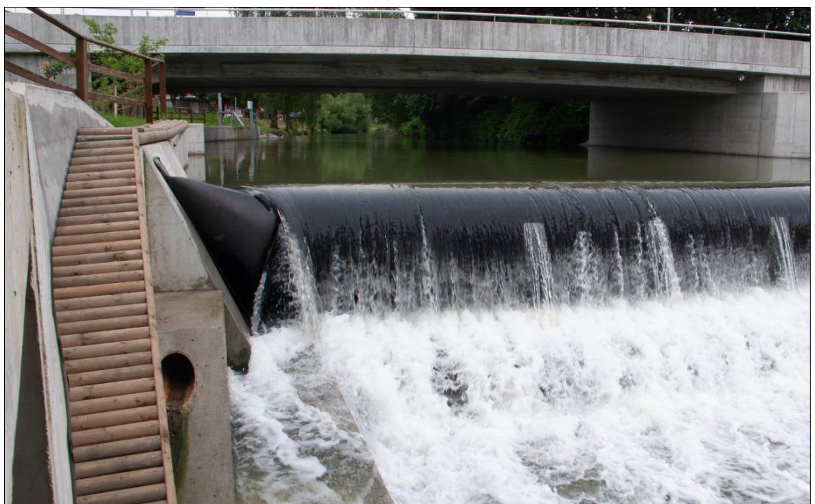
Abb. 7: An einer Staustufe angebrachte Biberrampe. Schon kleinere Absätze können für den Biber unüberwindbare Hindernisse darstellen. © Christof Angst, info fauna Nationale Biberfachstelle
