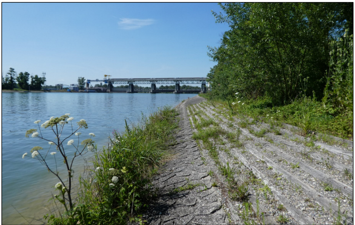
Abb. 9: Ausstiegsrampe am Rhein. Im Hintergrund ist das für den Biber auf dem Wasserweg unpassierbare Bauwerk eines Stauwehres zu erkennen. Die angelegten Strukturen aus Steinschüttungen, Holzbalken und gepflanzten Gehölzen sollen dem Biber einen leichteren Ausstieg aus dem Gewässer ermöglichen. Der Standort der Rampe wurde so gewählt, dass aussteigende Tiere direkt in ein weiteres angrenzendes Fließgewässer geleitet werden. © Jérémie Tudoux, TRUZ
