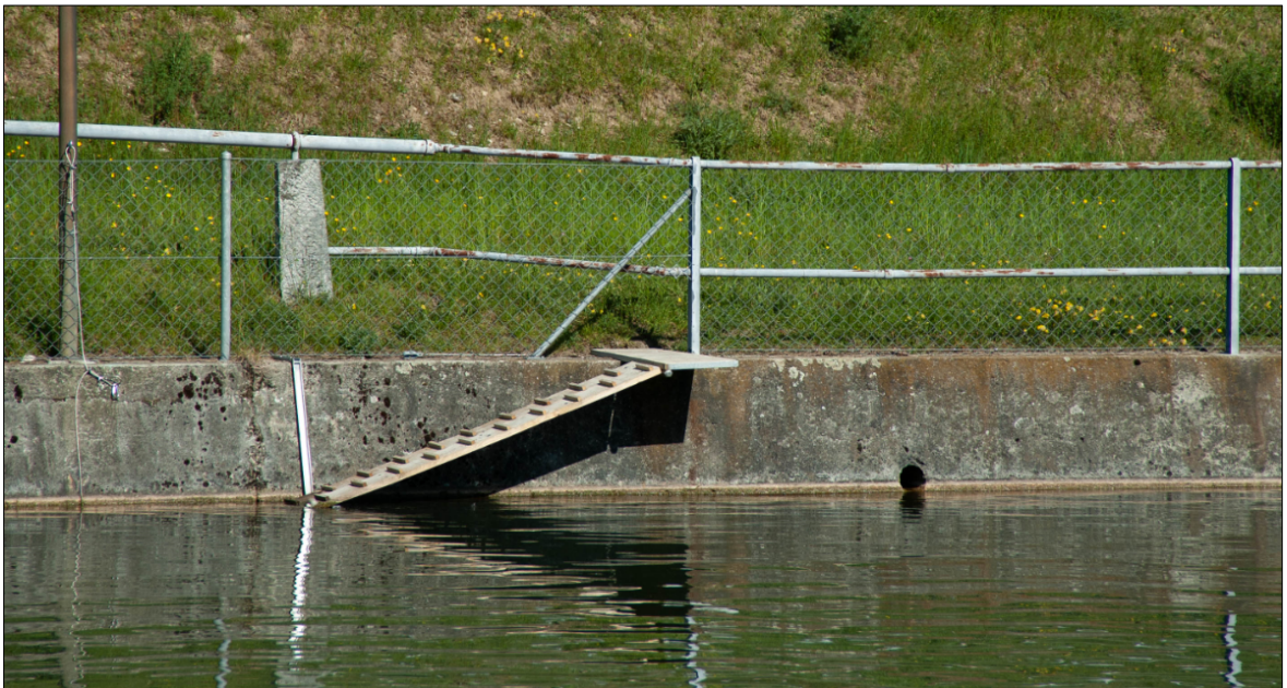
Abb. 2: Ausstiegshilfe an einem Becken. Die steile Ufermauer kann vom Biber ohne Ausstiegshilfe kaum überwunden werden. © Christof Angst, info fauna Nationale Biberfachstelle
