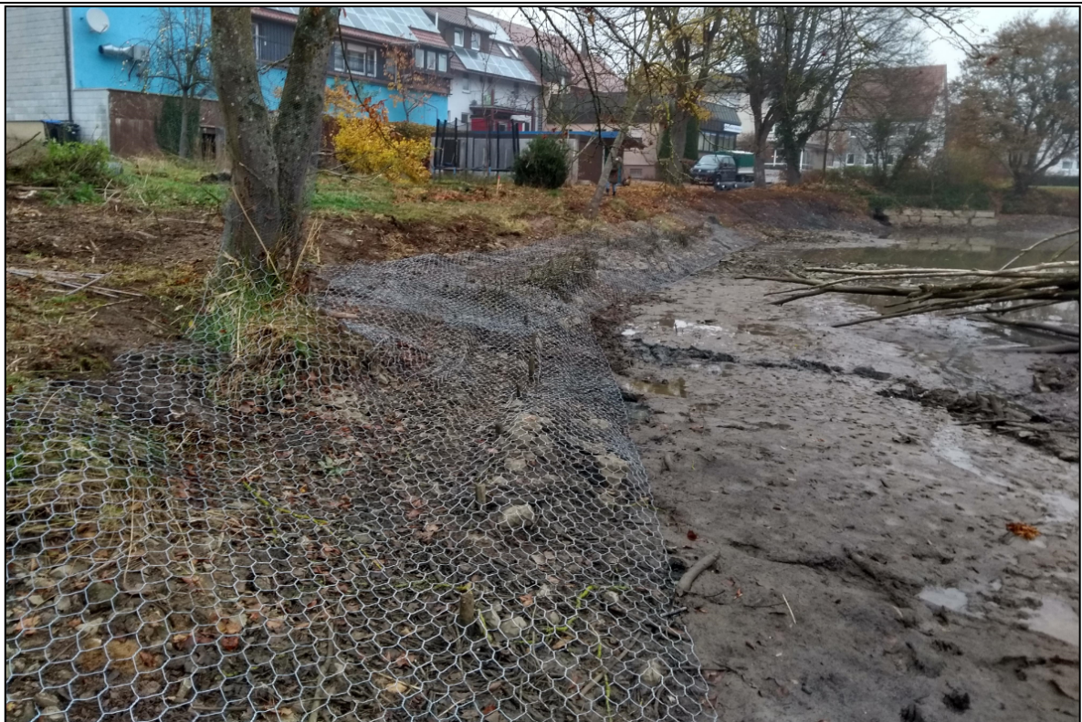
Abb. 3: Auf ein Gewässerufer aufgelegtes Biberschutzgitter in der Bauphase. © Timo Skorzak
