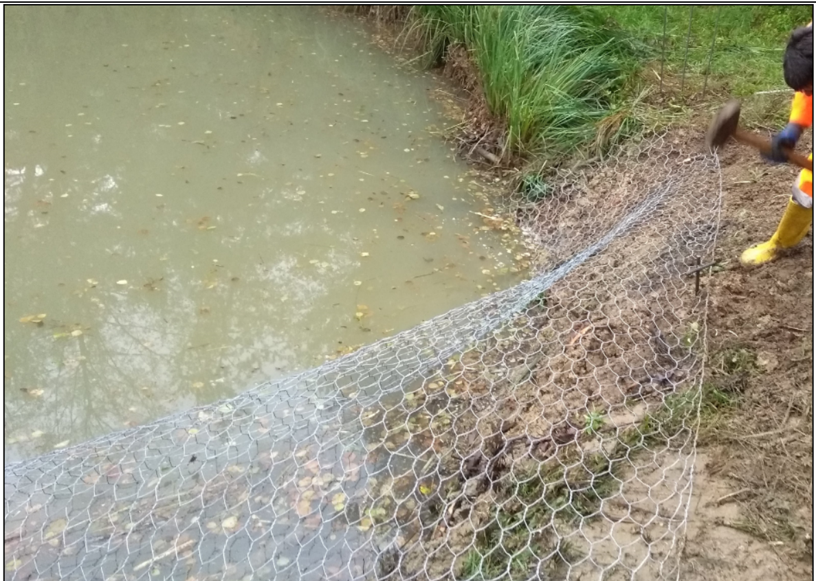
Abb. 4: Einschlagen von Kreuzankern zur Befestigung des Biberschutzgitters. © Timo Skorzak
