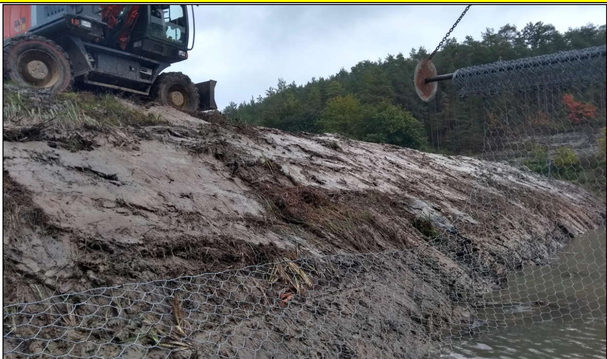
Abb. 1: Einbau von Biberschutzgitter mittels Bagger. Die einzelnen Gitterbahnen können so leichter auf das Ufer aufgelegt werden. © Timo Skorzak
