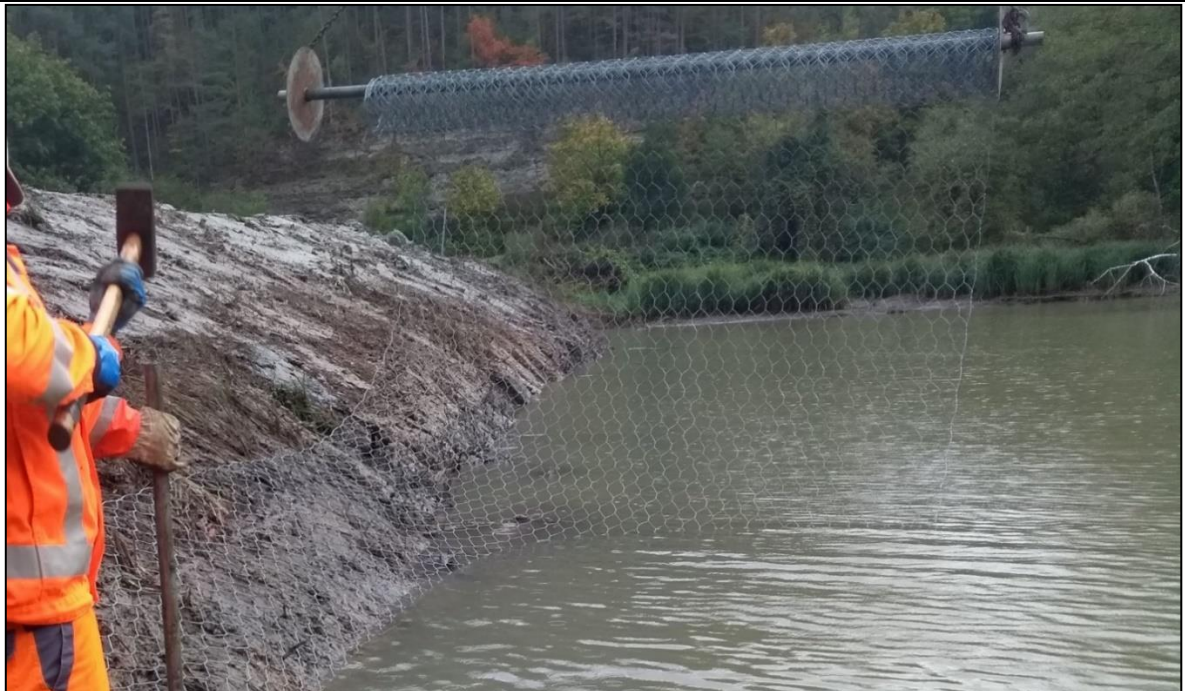
Abb. 2: Einbau Biberschutzgitter mittels Bagger. Wichtig ist, dass das Gitter möglichst bis zum Gewässergrund auf das zu schützende Element (hier ein Damm) gelegt wird. Hierzu kann es notwendig sein, vorab den Wasserspiegel abzusenken. © Timo Skorzak
