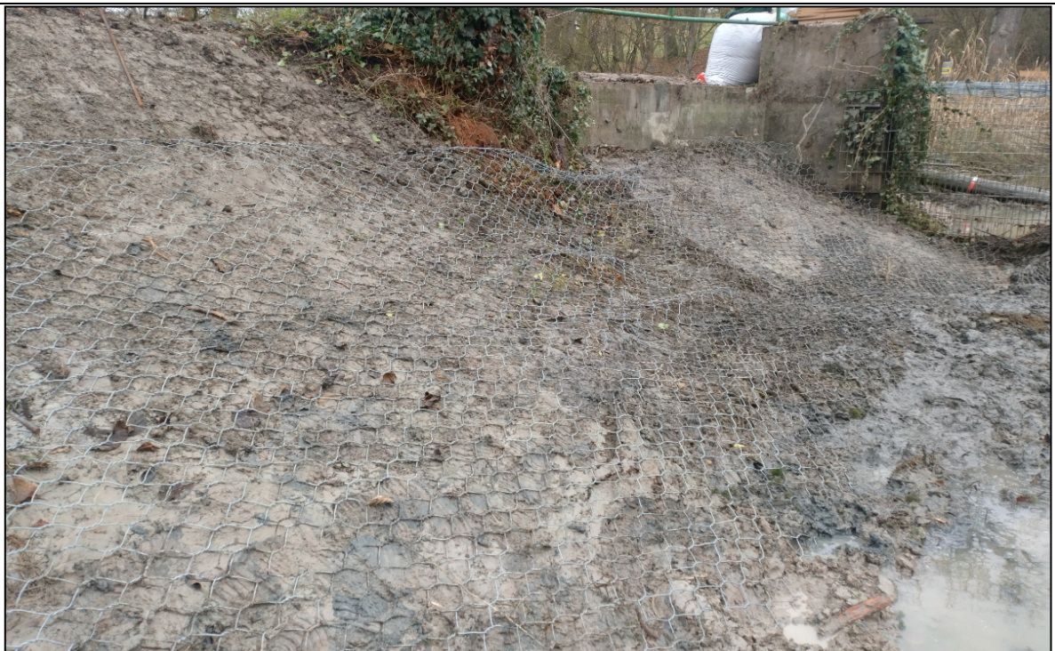
Abb. 5: Eingebautes Biberschutzgitter. © Timo Skorzak
