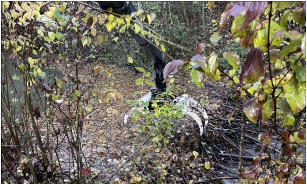
Abb. 1: Absenken eines Biberdammes mittels Greifer. © Timo Wesner
