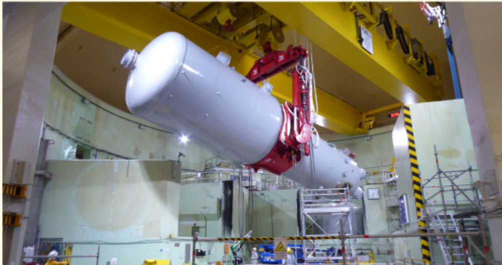
Ausheben Dampferzeuger
