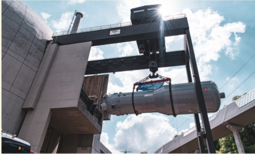
Dampferzeuger am Hubgerüst
