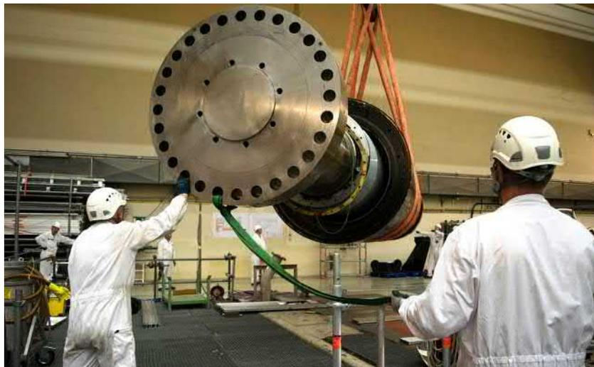
Einige Anlagenteile außerhalb von Gebäuden/Gebäudeteilen des Kontrollbereichs könnten mit radioaktiven Stoffen geringfügig verunreinigt sein. Beim Abbau solcher kontaminierter oder möglicherweise kontaminierter Anlagenteile werden daher geeignete Strahlenschutzmaßnahmen getroffen.
