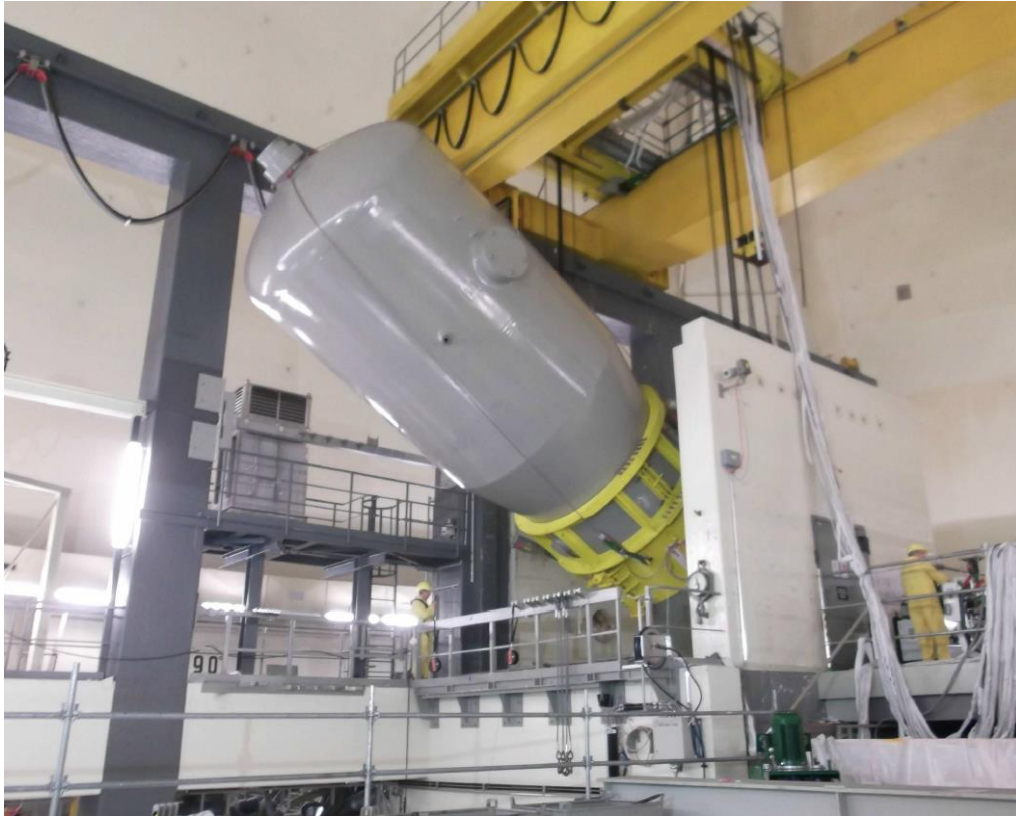
Abbildung 2: Abbau eines Dampferzeugers im Kernkraftwerk Obrigheim im Rahmen der 2. AG (Quelle EnKK)
