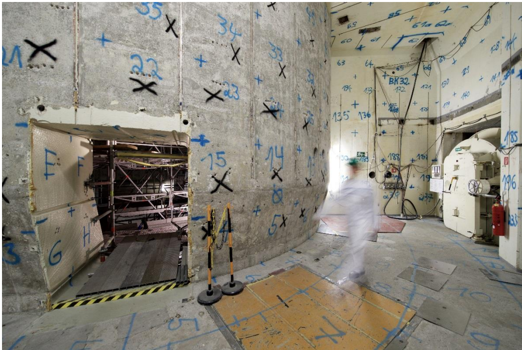
Abbildung 5: Reaktorgebäude des sich im fortgeschrittenen Rückbau befindlichen MZFR (Markierungen an den Gebäudedestrukturen rühren aus Messungen zum Zweck der Freigabe her) (Quelle KTE)
