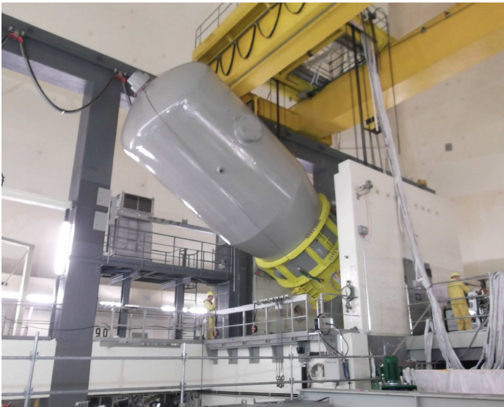
Abbildung 5: Abbau eines Dampferzeugers im Kernkraftwerk Obrigheim im Rahmen der 2. SAG
