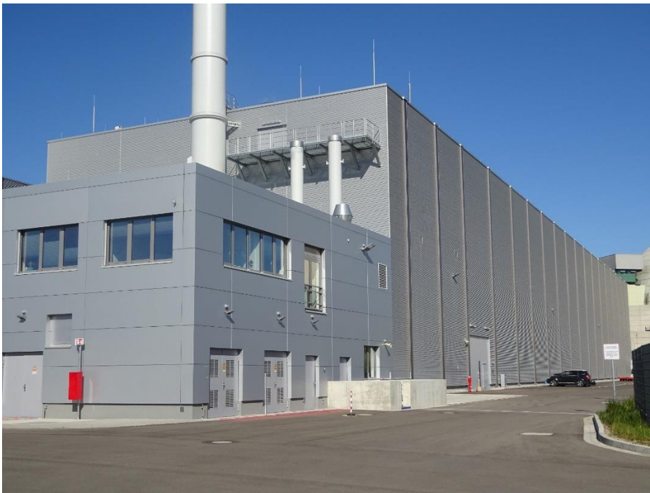
Abfall-Zwischenlager Philippsburg (AZP)
