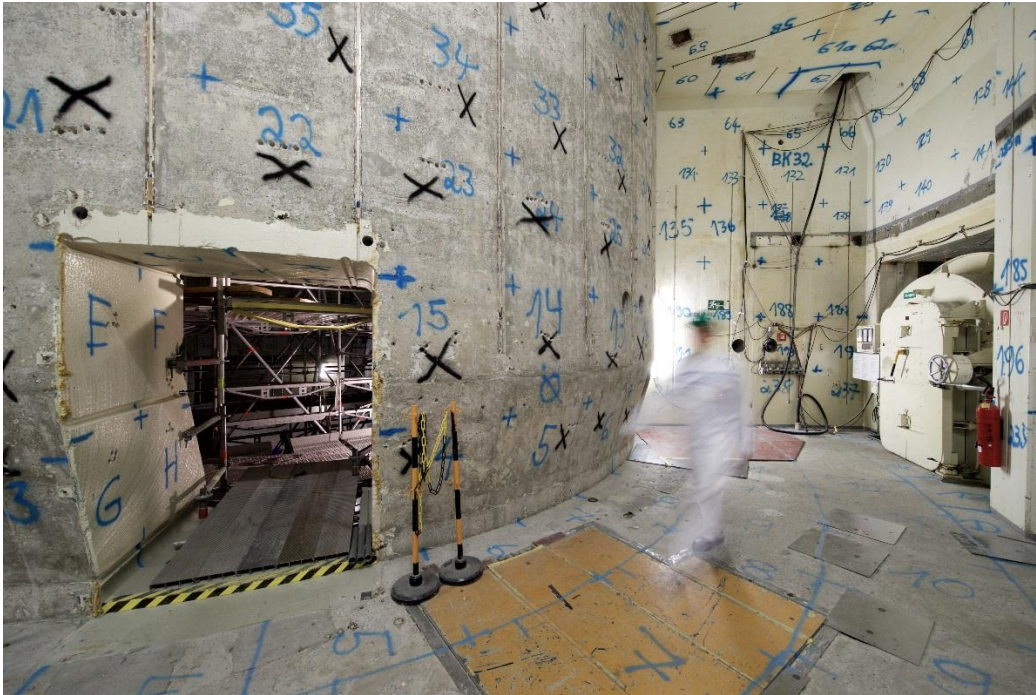
Abbildung 4: Reaktorgebäude des sich im fortgeschrittenen Rückbau befindlichen MZFR (Markierungen an den Gebäudestrukturen rühren aus Messungen zum Zweck der Freigabe her)
