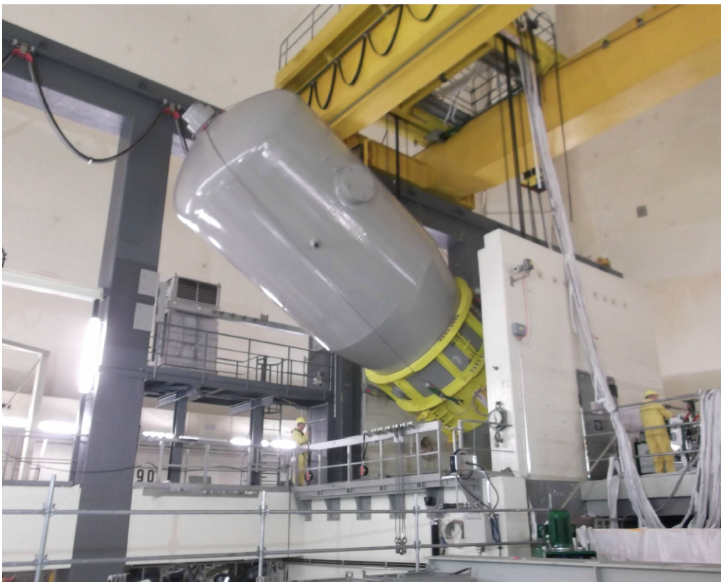
Abbildung 2: Abbau eines Dampferzeugers im Kernkraftwerk Obrigheim im Rahmen der 2. AG
