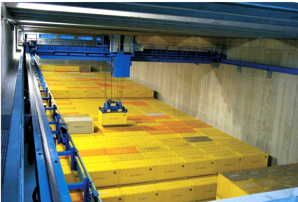
Abbildung 9: Zwischenlager bei den Entsorgungsbetrieben der KTE
