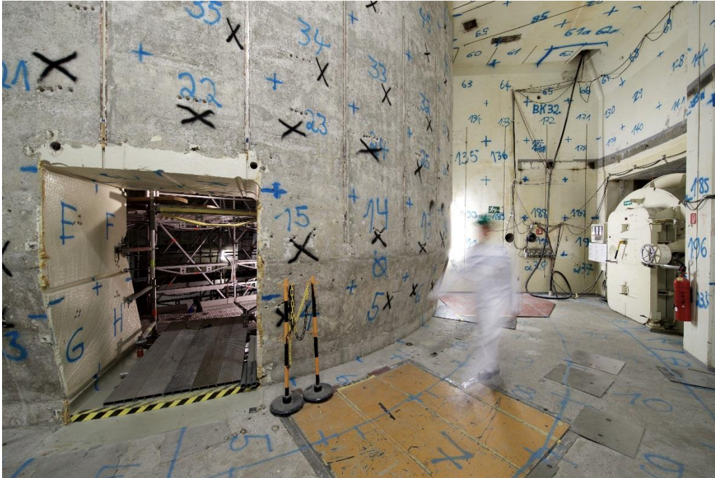
Abbildung 5: Reaktorgebäude des sich im fortgeschrittenen Rückbau befindlichen MZFR (Markierungen an den Gebäudestrukturen rühren aus Messungen zum Zweck der Freigabe her)
