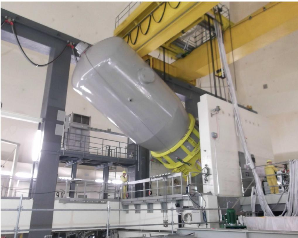
*Abbildung 5: Abbau eines Dampferzeugers im Kernkraftwerk Obrigheim im Rahmen der 2. AG*
