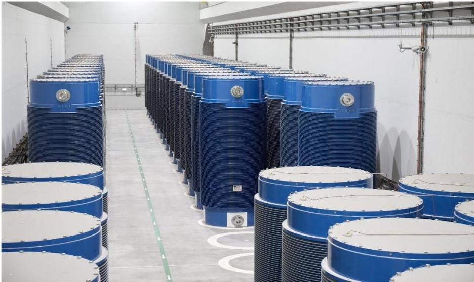
Abbildung 11: Brennelemente-Zwischenlager Neckarwestheim
