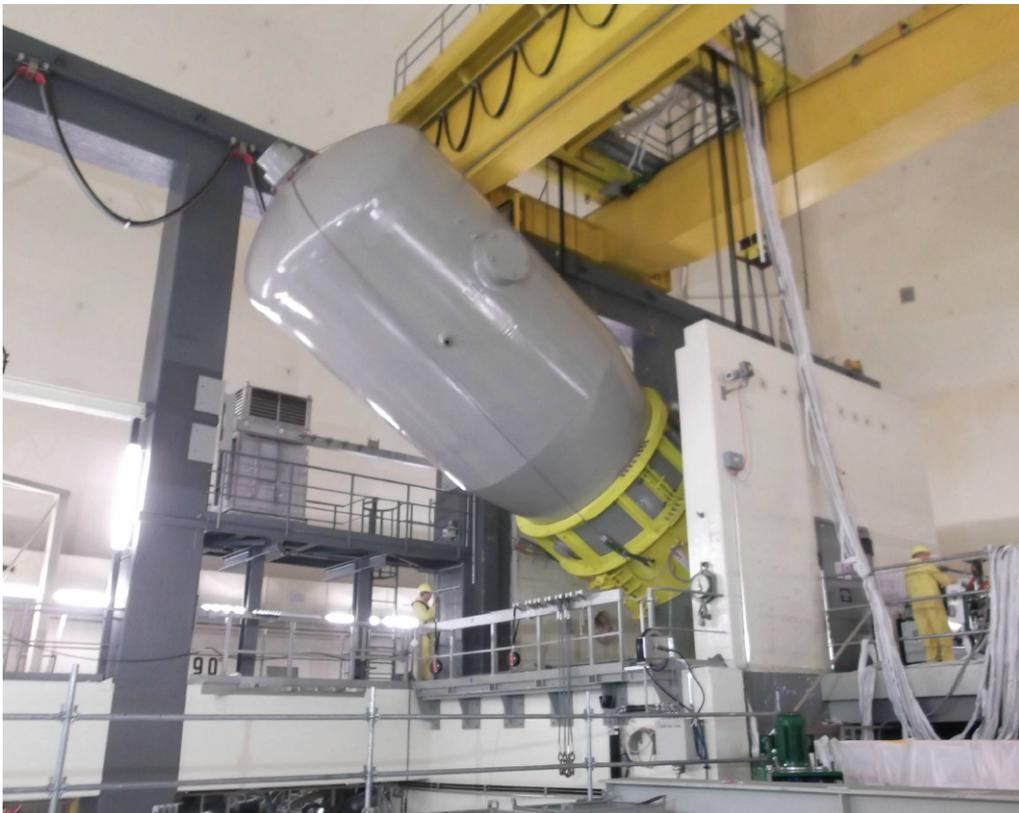
Abbildung 5: Abbau eines Dampferzeugers im Kernkraftwerk Obrigheim im Rahmen der 2. AG
