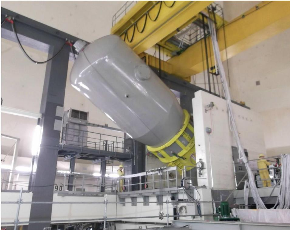
**Ausbau des Dampferzeugers im Kernkraftwerk Obrigheim**
