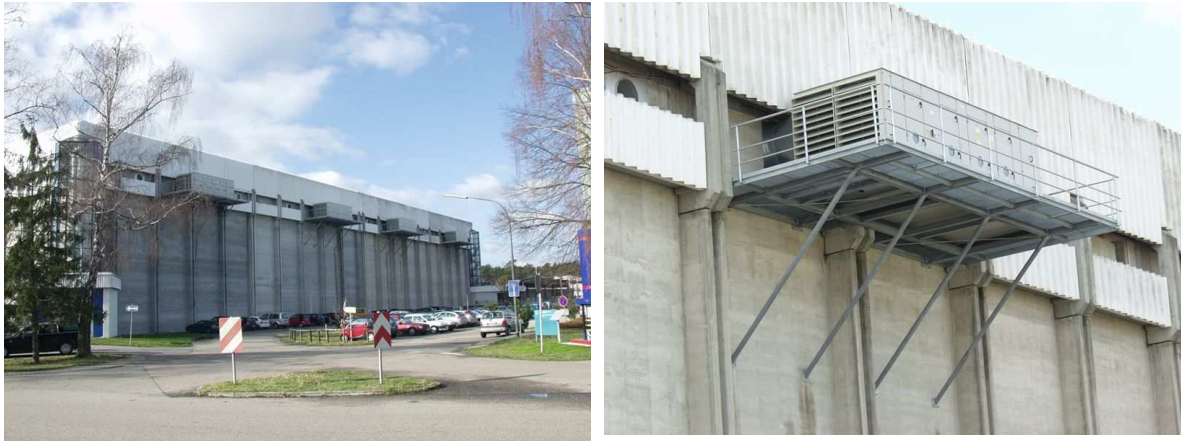
Abbildung 3-2: Zwischenlager 526 der HDB mit Zusatzlüftung (links), Nahaufnahme des Gebläses mit Filter (rechts)
