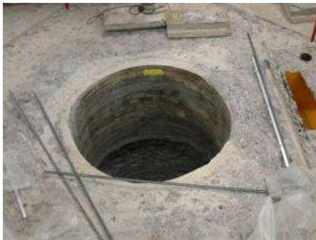
**Abbildung 4-7: TRIGA HD II – Blick in den Reaktorraum nach Rückbau des biologischen Schields**
