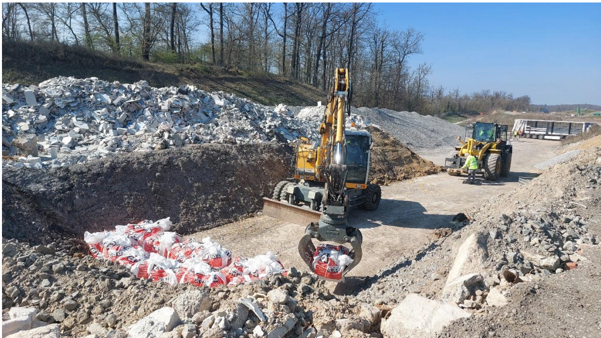
Abbildung 3: Einbau der freigegebenen Gebinde in die Deponie Hamberg (Quelle: UM)
