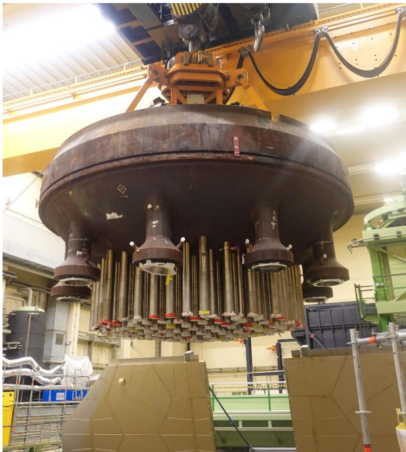
Abbildung 2: Ausheben der RDB-Kalotte (Quelle: EnBW)
