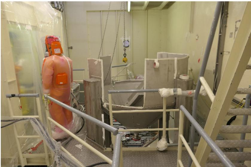
Abbildung 9: Sonderkonzentratsystem: Demontage Sonderkonzentratbehälter (Quelle: KTE)
