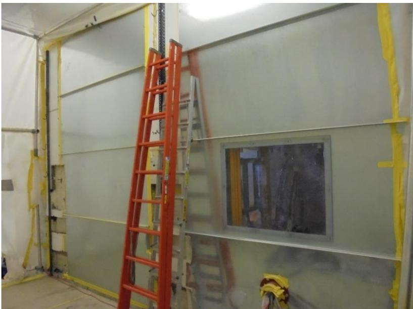
Abbildung 11: Bedienwand zur BZ 4 mit komplett ausgebauten Bedienwandelementen und lüftungstechnisch verschlossen (Quelle: KTE)
