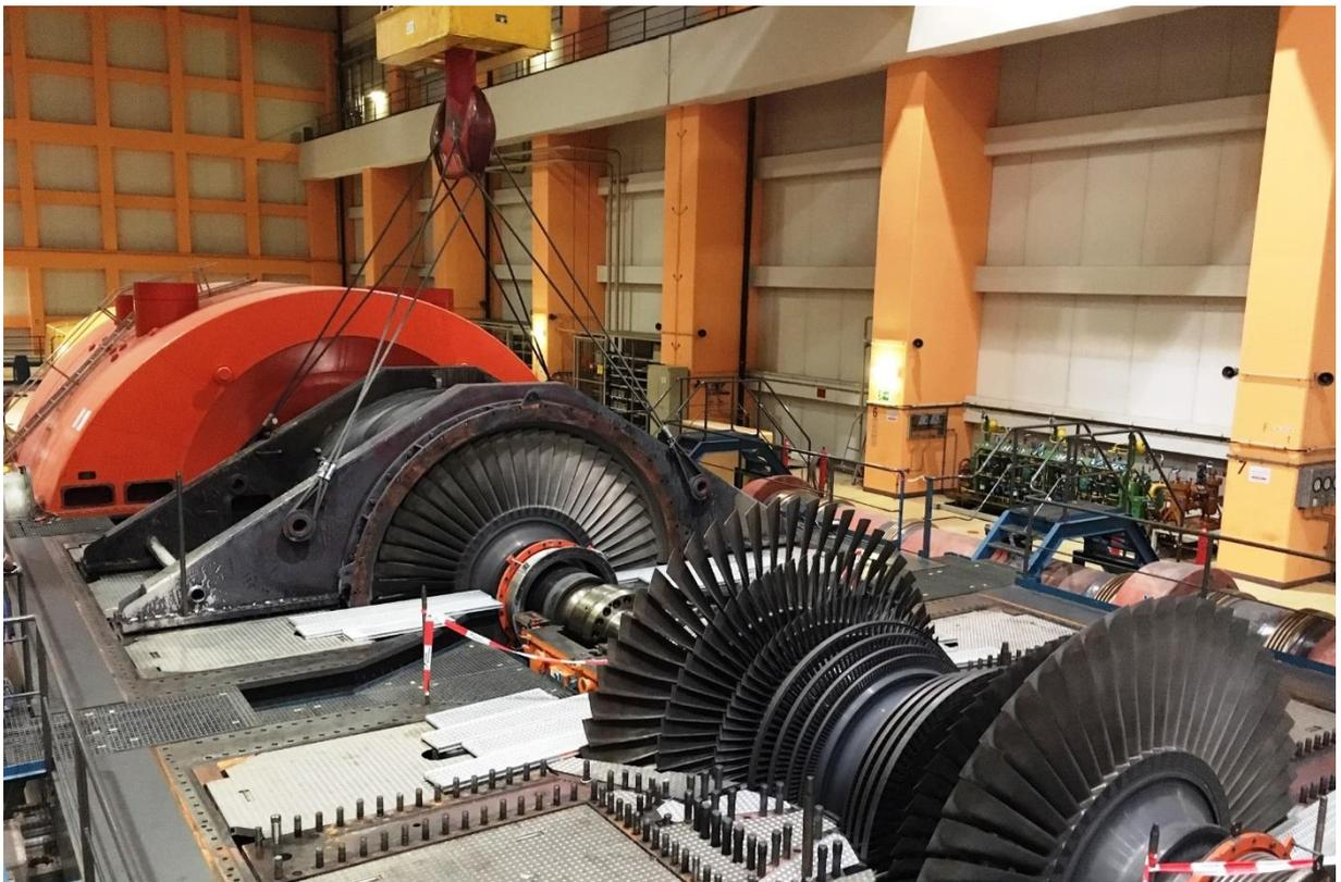
Abbildung 1: Aushebung eines Dampferzeugers aus seiner ursprünglichen Einbauposition im Reaktorgebäude (oben) und Demontage einer Niederdruckturbine im konventionellen Maschinenhaus (unten) im GKN I. Quelle: EnBW Energie Baden-Württemberg AG.
