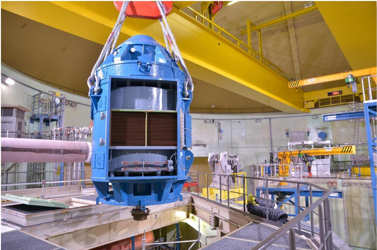
Abbildung 6: Der rund 40 Tonnen schwere Motor einer der drei Hauptkühlmittelpumpen nach seiner Demontage im Reaktorgebäude vom GKN I. Quelle: EnBW Energie Baden-Württemberg AG.
