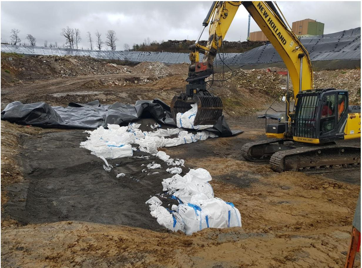
*Abbildung 5: Ablagerung von zur Beseitigung auf einer Deponie freigegebenem Material im Einbaufeld der Deponie Sansenhecken des Neckar-Odenwald-Kreises (Quelle: UM).*
