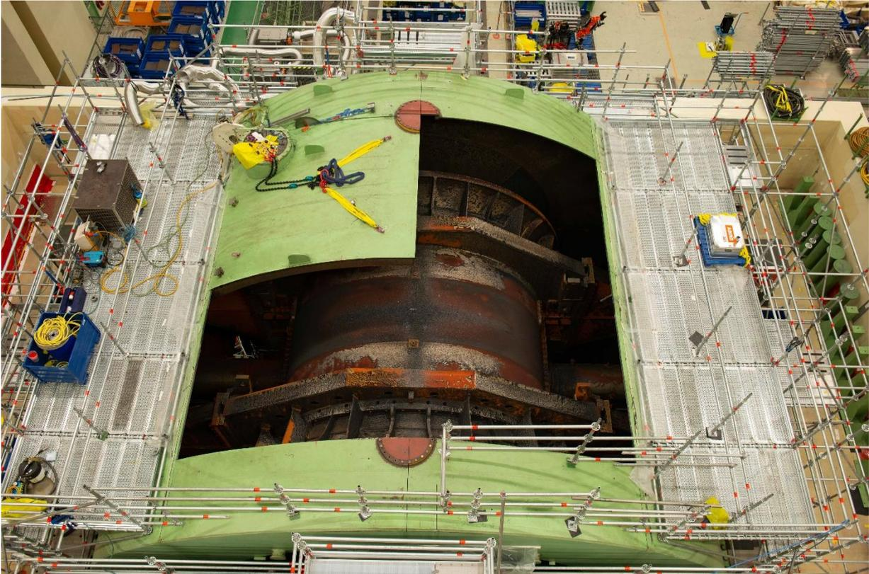
Abbildung 4: Zerlegung der Abdeckhauben der Niederdruck-Turbine im Maschinenhaus von KKP 1 (Quelle: EnBW Kernkraft GmbH)
