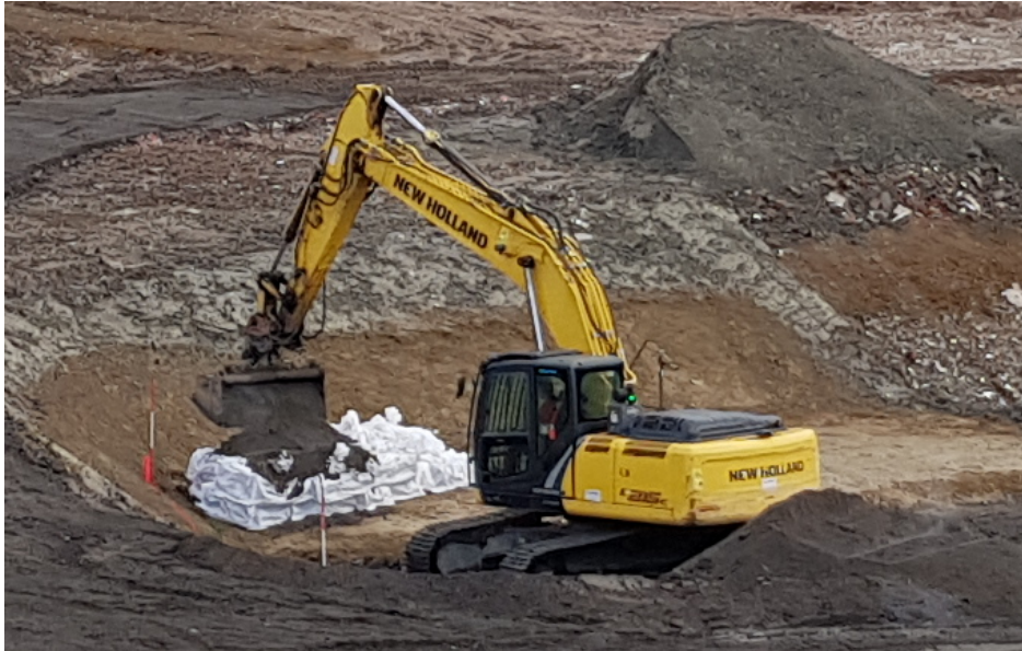
Abbildung 1: Einbau von 20 zur Beseitigung auf einer Deponie freigegebenen Betonblöcken aus dem Kernkraftwerk Obrigheim in die Deponie Sansenhecken des Neckar-Odenwald-Kreises. (Quelle: UM)
