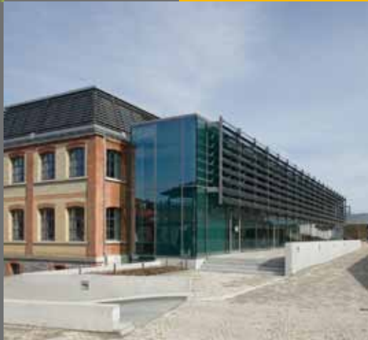
Eine alte Strickwarenfabrik wird nach der erfolgreichen Sanierung als Bürgerhaus, Musikschule und Volkshochschule genutzt.
