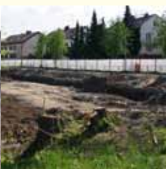
Altlastenflächen erhalten nach der Sanierung ein neues Gesicht.
