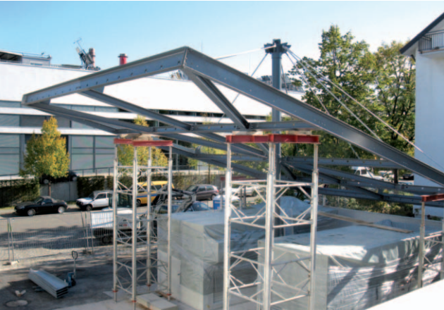
Abbildung 38: Wasserstoff-Tankstelle am Fraunhofer ISE, Freiburg – im Bau
