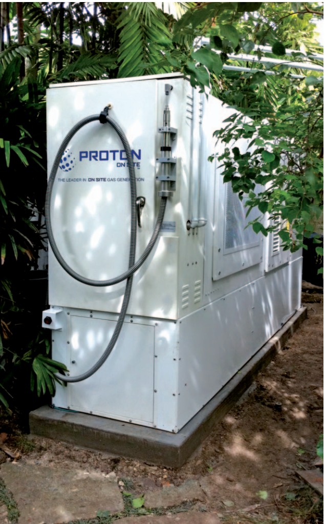
Abbildung 16: Prototyp einer dezentralen Wasserstoff-Tankstelle „Home refueller“, Aufstellung an einem Privathaus (Quelle: Proton Onsite)
