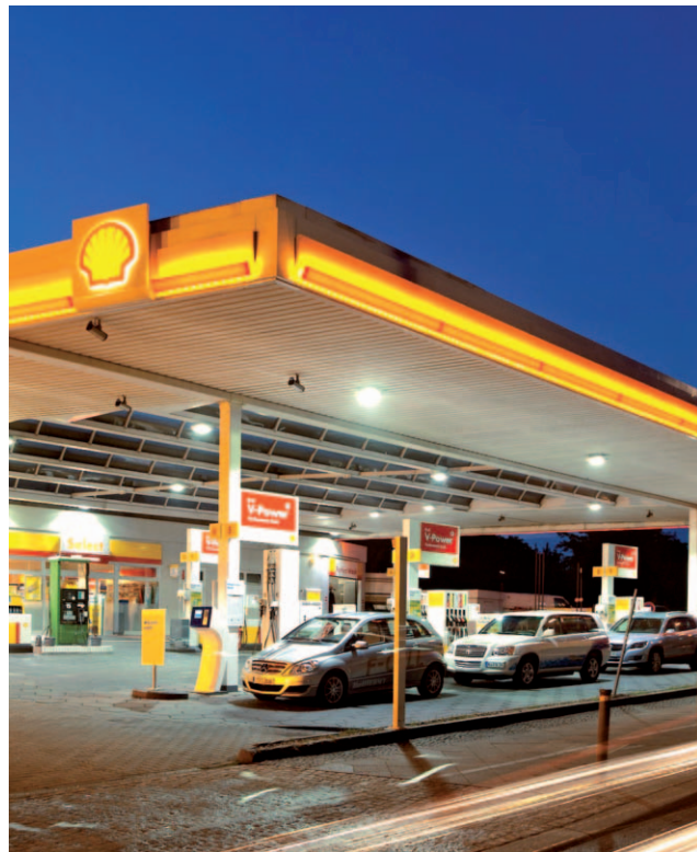
Abbildung 4: Wasserstoff-Tankstelle Berlin Sachsensdamm (Quelle: Shell)
