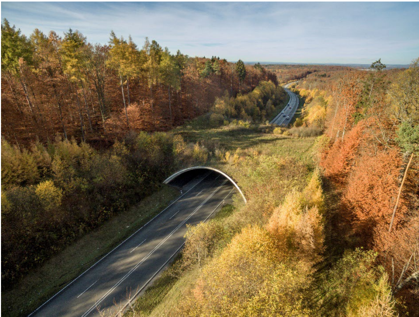
Grünbrücke Hörnleswald an der B 464 bei Böblingen (@ M. Stollberg)
