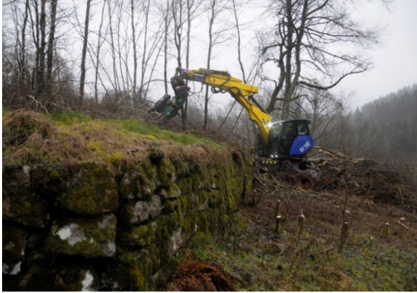
Links: Schwerstarbeit im Hang - mit Hilfe eines Schreitbaggers wird eine Trockenmauer freigestellt (© A. Koch)
