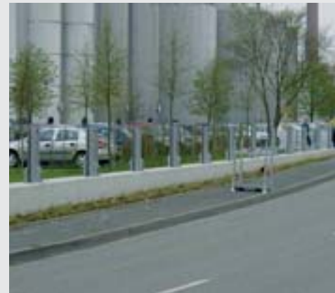
Errichtung eines Dammbalkensystems zum Schutz einer Industrieanlage.
