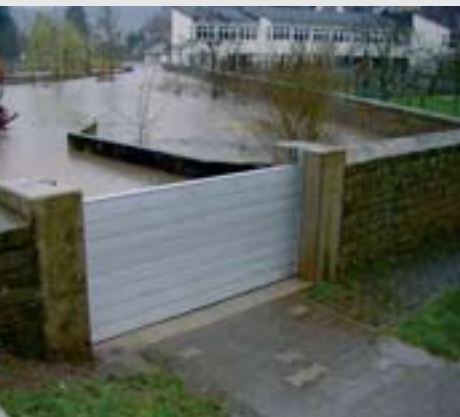
Temporäre Abschirmung im Einsatz
