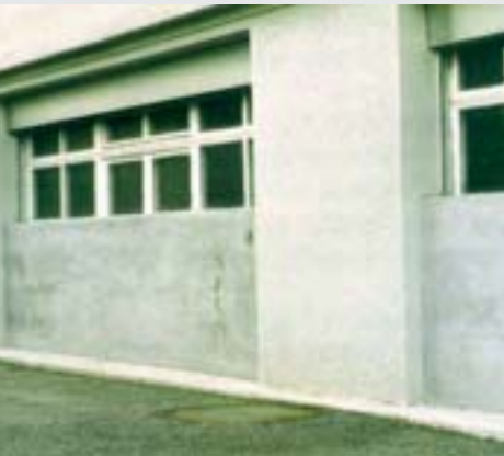
Abdichtung von Öffnungen (permanent) durch Vormauer
