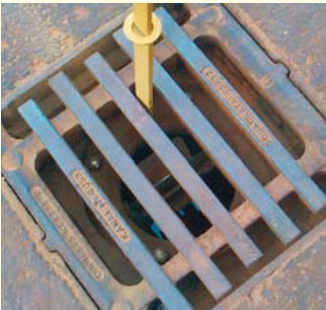
Kanäle werden durch festinstallierte Klappen oder mobile Verschlüsse gegen das Eindringen von Wasser geschützt
