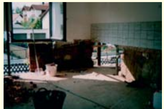
Mauerwerksaustausch infolge Ölverschmutzung (Kehlheim 1999)
