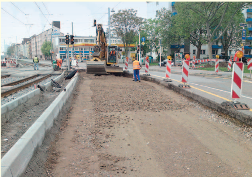
Abb. 8: STRASSENBAUSTELLE IM ZWEITEN BAUABSCHNITT „SÜDTANGENTE“
