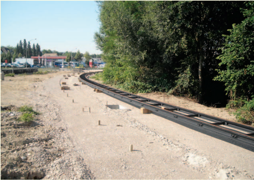
Abb. 7: STRASSEN-/STADTBAHNBAUSTELLE „STADTBAHNVERLÄNGERUNG ZÄHRINGEN“
