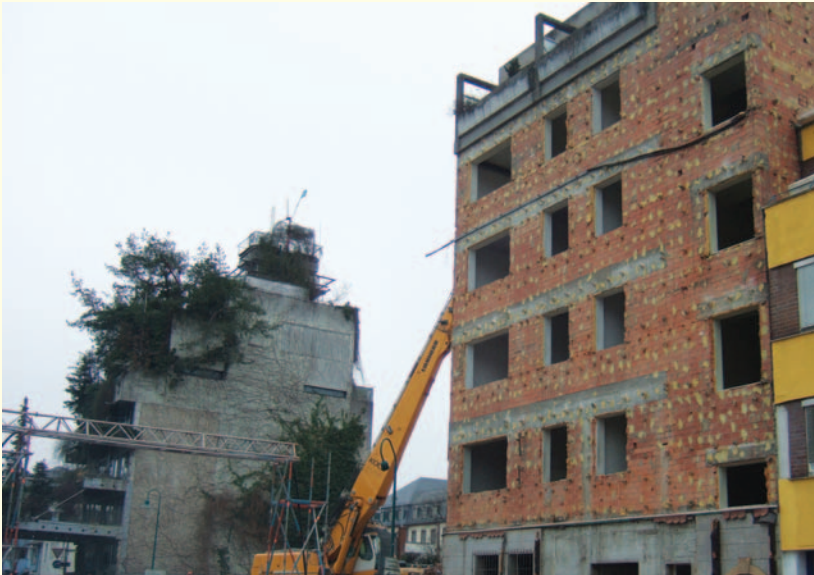
Abb. 1: SELEKTIVER RÜCKBAU EINES GEBÄUDES NACH ENTKERNUNG
