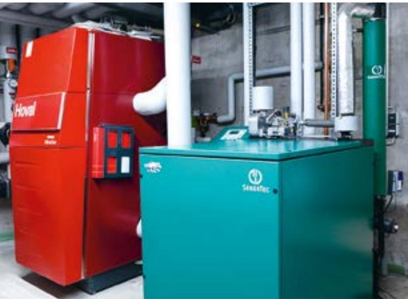
*Das Blockheizkraftwerk im Autohaus erzeugt das ganze Jahr über Strom und Wärme.*
