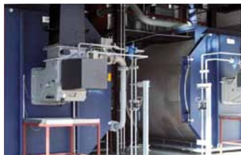
Bild 3: Heizkessel (Großwasserraumkessel)
