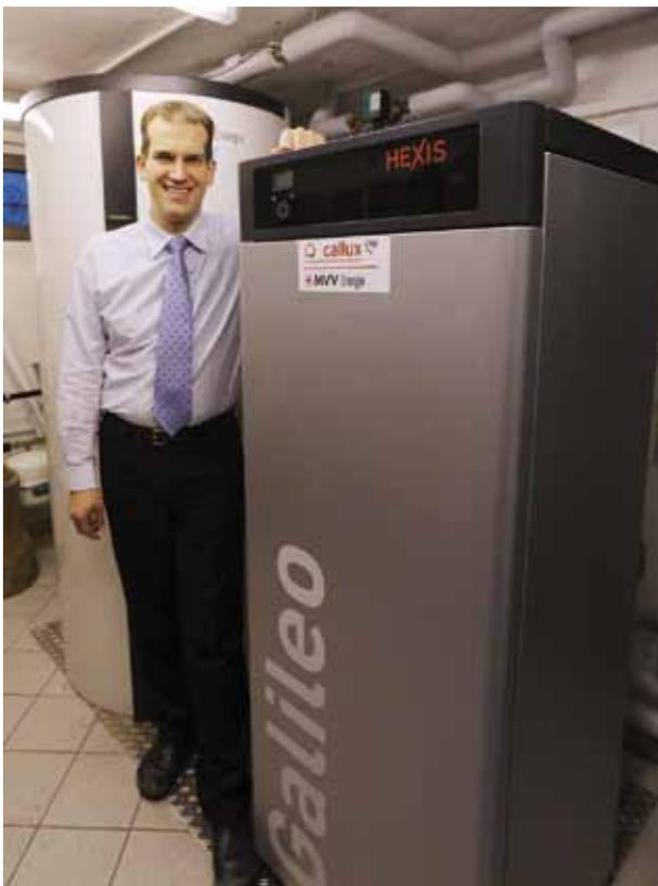
Bild 2: Typische Installation einer Hexis-Brennstoffzellenheizung
