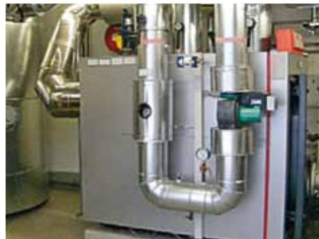
Bild 2: Spitzenlastkessel
