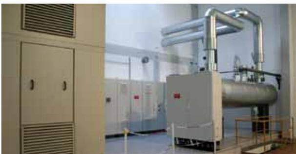
Bild 2: Elektrokessel 5 MW<sub>th</sub>
