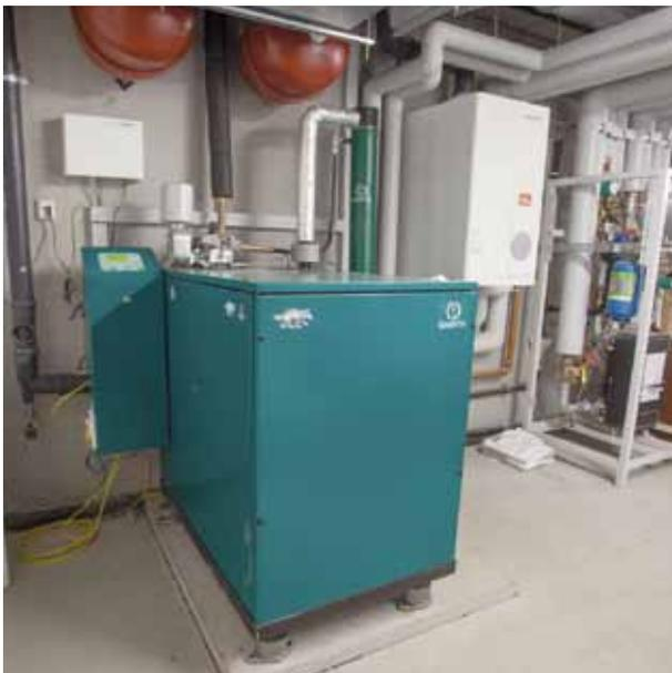
Bild 2: Eins von vier Dachs-Blockheizkraftwerken
