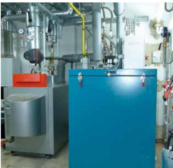
Die Altenwohnanlage Hans-Rehn-Stift wurde im Jahr 1977 erbaut. Nach 30 Jahren sollte das Hans-Rehn-Stift sowohl baulich als auch anlagentechnisch saniert werden. Grundbestandteil der neuen Energiezentrale ist eine Wärmepumpe. Darüber hinaus wird Wärme durch ein Blockheizkraftwerk (BHKW), einen Gas-Niedertemperaturkessel und Solarkollektoren erzeugt. Der Umbau der Heizzentrale erfolgte bei laufendem Betrieb des Alten- und Pflegeheims.
