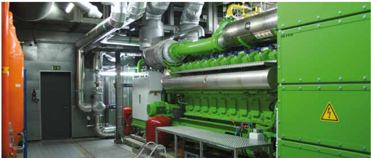
Bild 1: Gasmotor 3,35 MW<sub>el</sub>, von insgesamt 4 Motoren des BHKW Obere Viehweide
