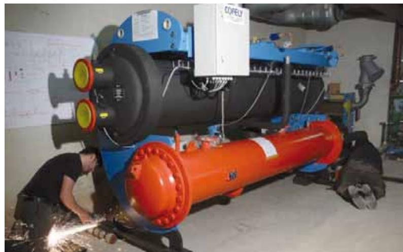
Bild 3: Einbau Kältemaschine
