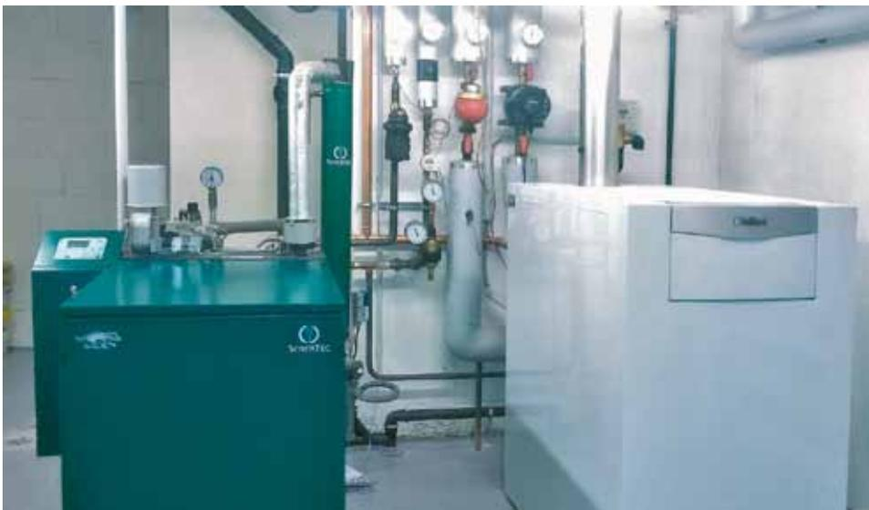
Bild 2: BHKW-Dachs mit Spitzenlastkessel
