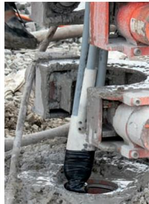
*Kopf einer Erdwärmesonde.*
