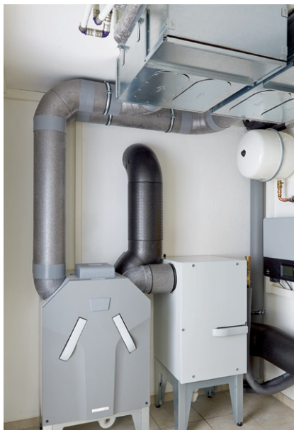
Zentrales Lüftungsgerät mit Wärmerückgewinnung im Keller eines Passivhauses. Foto: FGK/Zehnder
