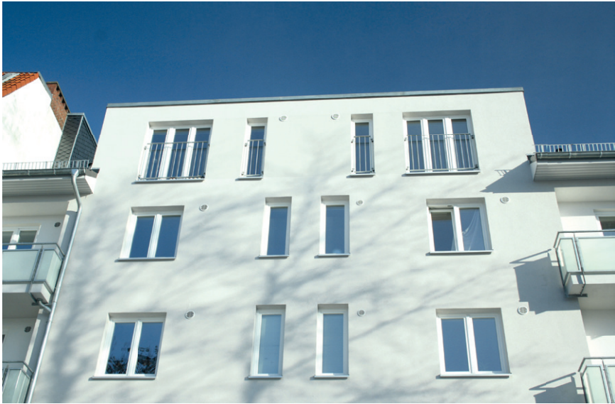
Außenluftansaugungen und Fortluftauslässe an der Fassade eines sanierten Mehrfamilienhauses mit KWL. Foto: FGK/Lunos/CO 2 -Sparhaus
