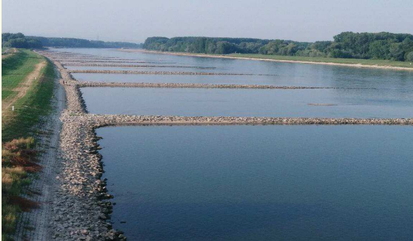
Niedrigwasser Anfang August 2018 am Rhein bei Karlsruhe Quelle: S. Plegnière/LUBW
