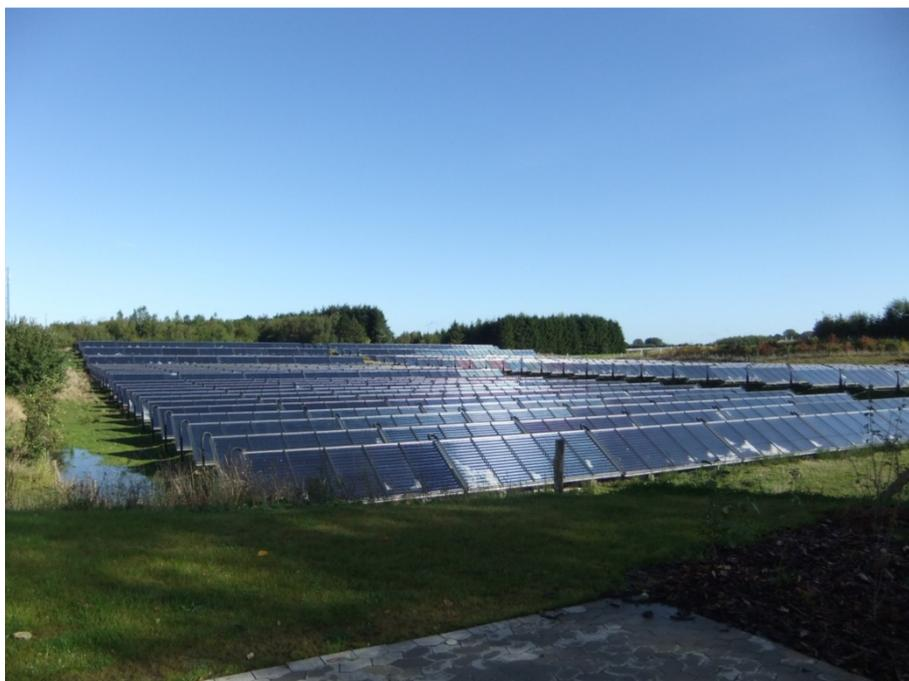
**Slika 3-3:** Slika dijela polja kolektora s kolektorskom površinom od 8.000 m<sup>2</sup> za potrebe podru nog grijanja u Brødstrupu, Danksa. Fotografija: H. Böhnisch.
