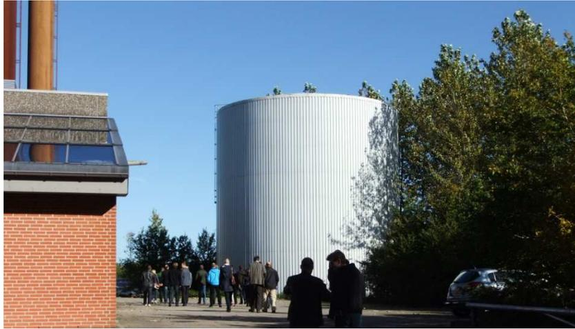
Slika 3-4: Me u-spremnik sustava podru nog grijanja s volumenom od 2.000m<sup>3</sup> Brædstrup, Danska. Foto: H. Böhnisch
