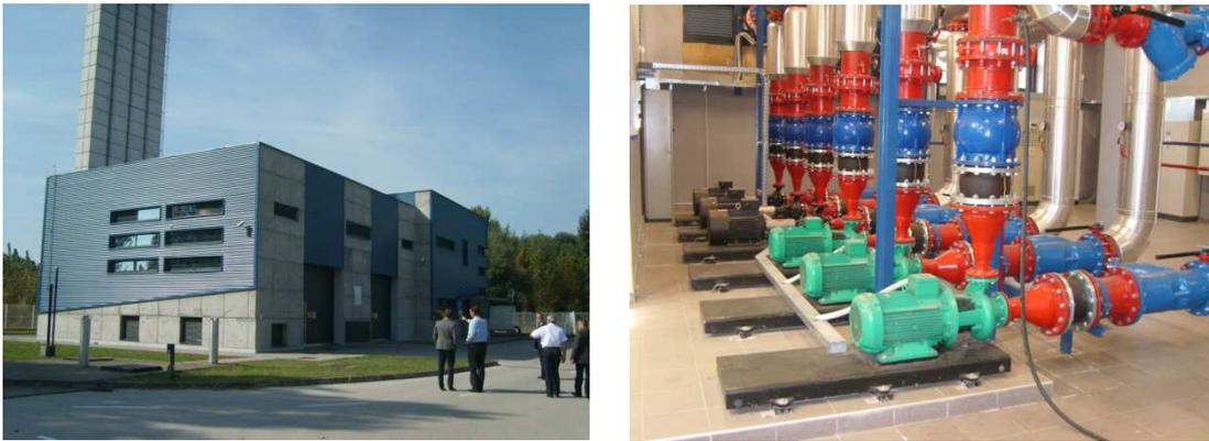
**Slika 4-1:** Zgrada kotlovnice Olajnica izvana (lijevo) i pogled na optičke pumpe za napajanje toplinske mreže vrelom vodom (desno). Fotografije: H. Böhnisch.
