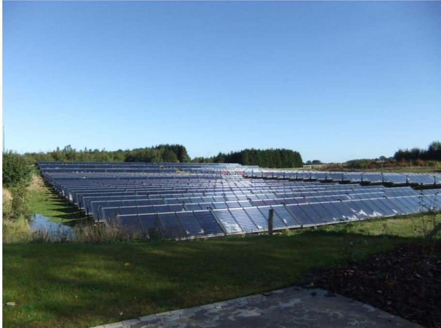
**Abbildung 3-3:** Ausschnitt aus dem Kollektorfeld mit 8.000 m<sup>2</sup> Kollektorfläche der Nahwärmeverorgung in Brødstrup, Dänemark. Foto: H. Böhnisch.
