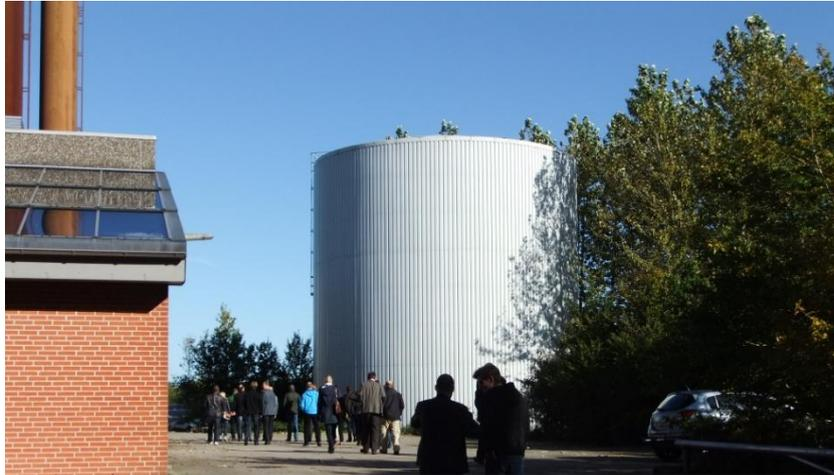
Abbildung 3-4: Pufferspeicher eines Nahwärmesystems mit 2.000 m<sup>3</sup> Volumen. Brædstrup, Dänemark. Foto: H. Böhnisch
