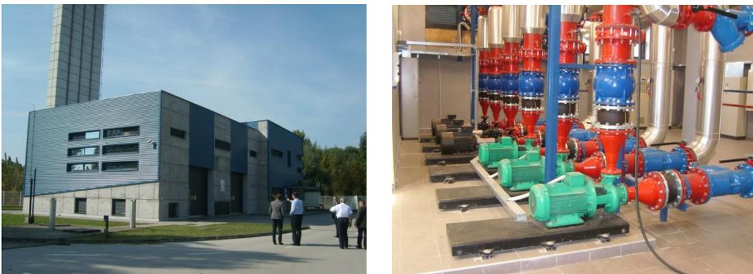
**Abbildung 4-1:** Außenansicht des Gebäudes der Kotlovnica Olajnica (links) und Blick in den Pumpenraum mit den Umwälzpumpen zur Einspeisung des heißen Wassers in das Wärmenetz (rechts). Fotos: H. Böhnisch.
