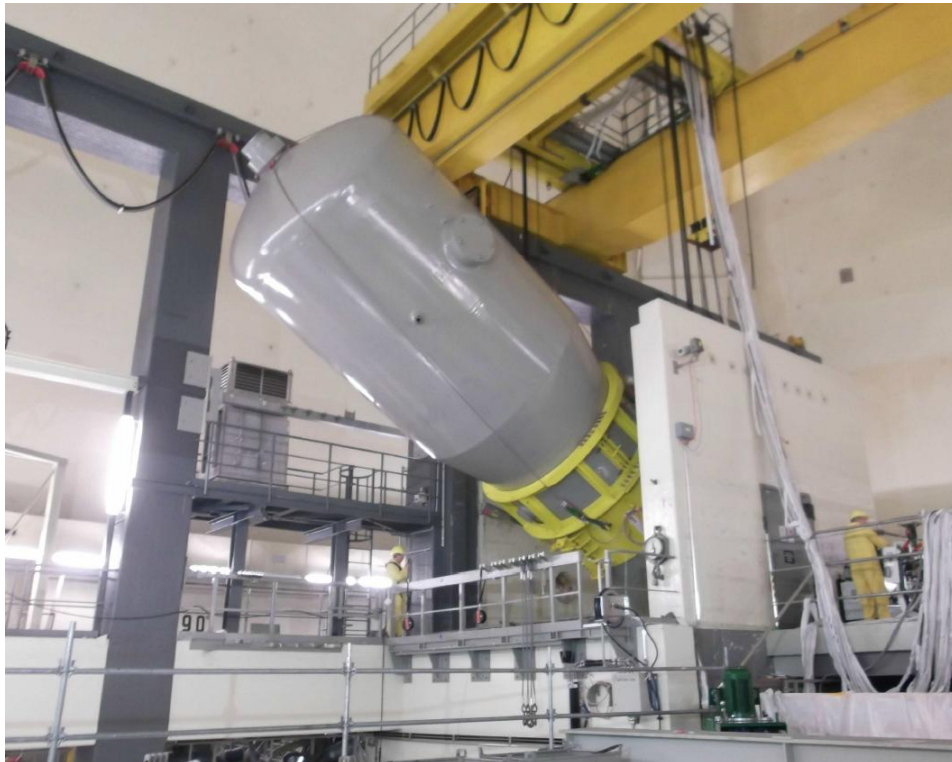
Ausbau des Dampferzeugers im Kernkraftwerk Obrigheim
