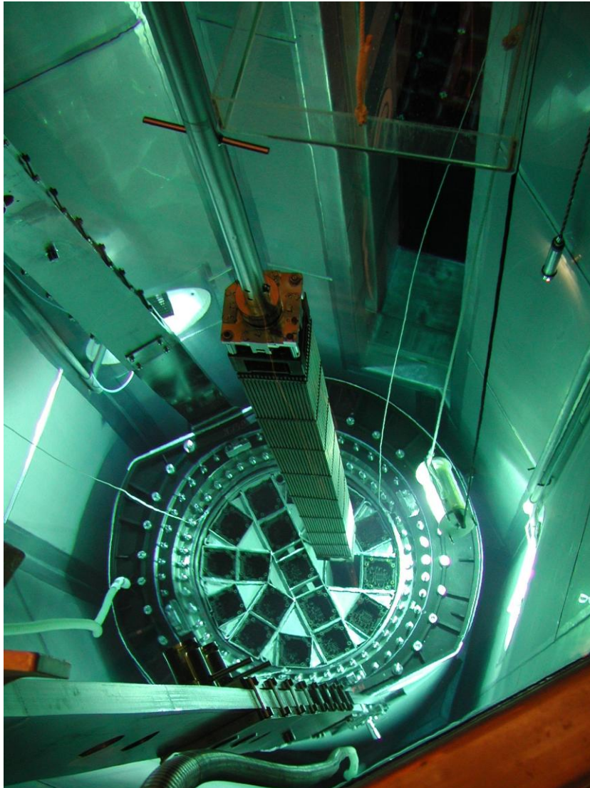
Beladung eines CASTOR-Behälters mit einem Brennelement (Beladung unter Wasser im Abklingbecken)
