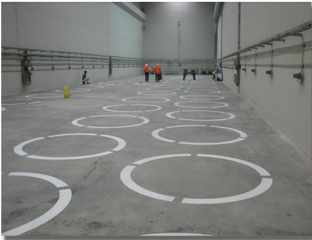
Zwischenlager Neckarwestheim vor der Einlagerung von CASTOR-Behälter im Jahr 2006 - Tunnelröhre (mit Stellplatzmarkierungen)
