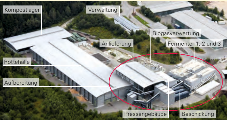
ABB. 9: UM EIN VERGÄRUNGSMODUL NACHGERÜSTETE KOMPOSTIERUNGSANLAGE IN PASSAU-HELLERSBERG (BUCHHEIT 2009)
