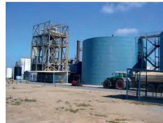
Abb. 24: Großtechnische Anlage zur Eindampfung von Biogasgülle in Spanien (Foto W-I 2009)
