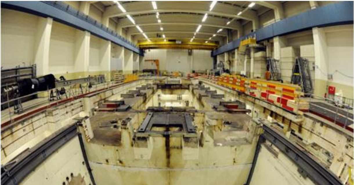
Kernkraftwerk Obrigheim: Rückbau der Maschinenhalle (Foto: Umweltministerium)
