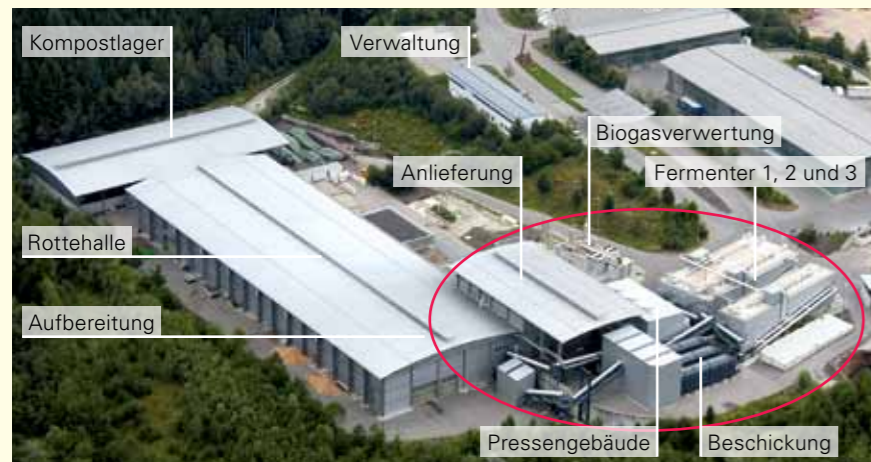
Abb. 7: Um ein Vergärungsmodul nachgerüstete Kompostierungsanlage in Passau-Hellersberg (Buchheit 2009)
